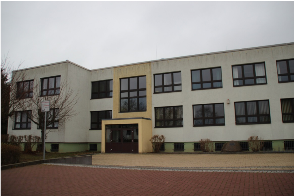
IP DD: Schule An der Lewitzmühle 82, Banzkow
