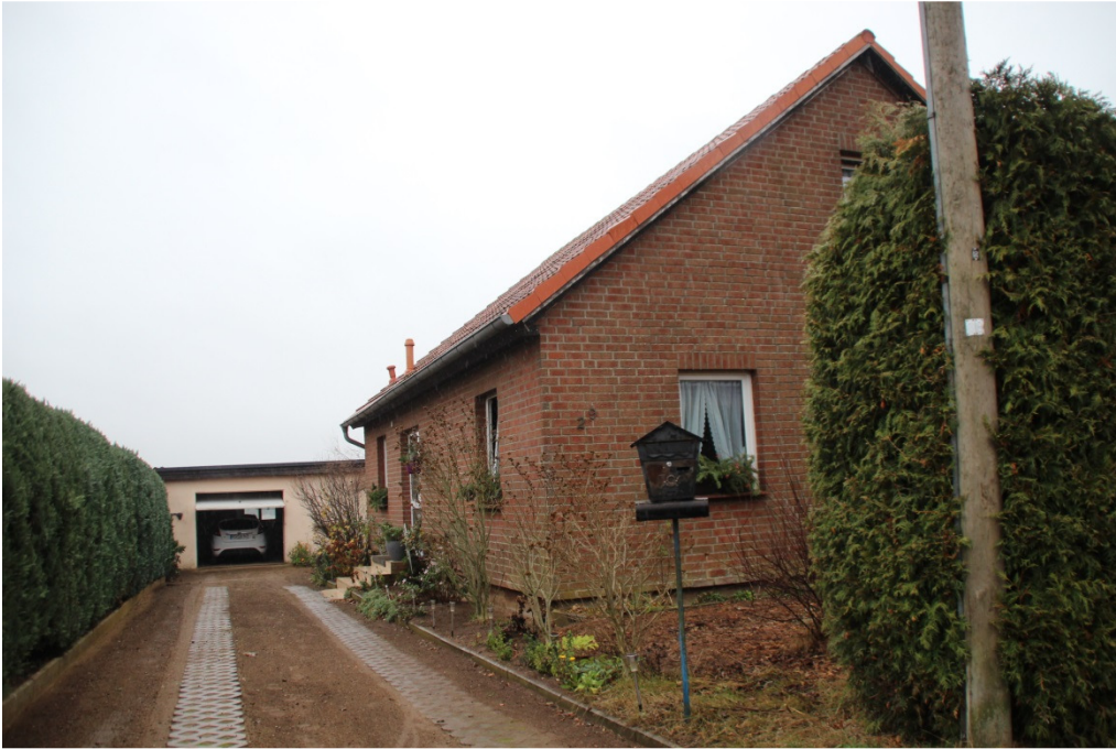
IP AR: Whs. Neue Straße 29, Plate
