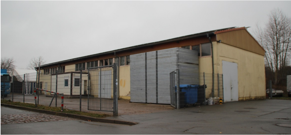
IP DC: Halle Plater Straße 14A, Banzkow
