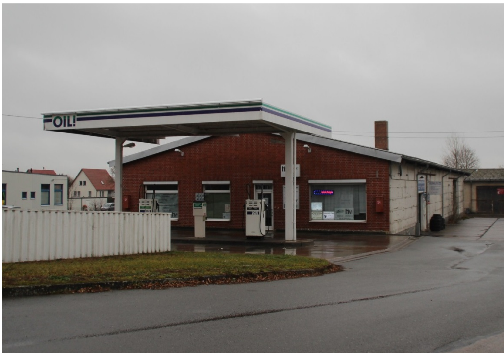
IP CT: Tankstelle Banzkower Straße, Plate
