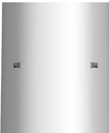
Abb. 4: Befuehrungsleuchte am Turm
