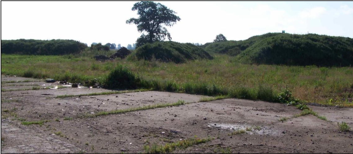
Abbildung 22: Lagerplatz im Nordosten des Vorhabens. Foto: STADT LAND FLUSS 16.06.2016.
