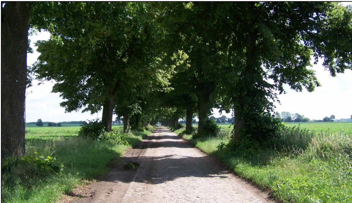
Abbildung 24: Kopfsteinpflasterstraße mit Lindenallee zwischen Wussentin und Dersewitz. Foto: STADT LAND FLUSS 16.06.2016.
