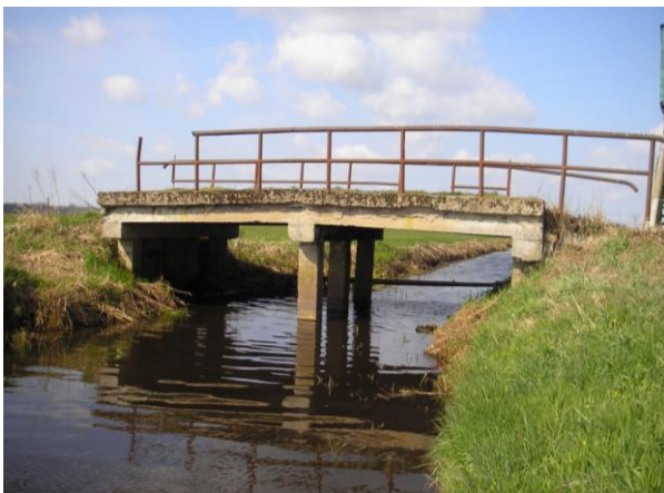
Abbildung 11: Überfahrt über die Kösterbeck (Bauwerk 1.4)
