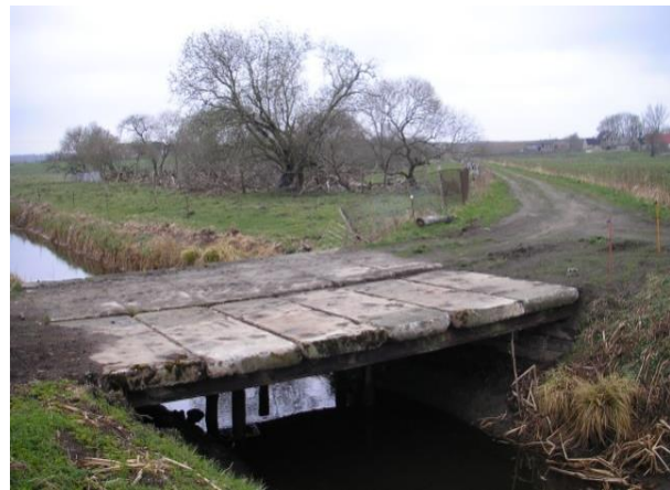
Abbildung 12: Überfahrt über den A-Graben (Bauwerk 1.1)
