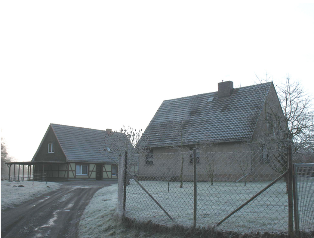
IP 02 Dambeck, Chausseestr. 20, Hinterhaus
