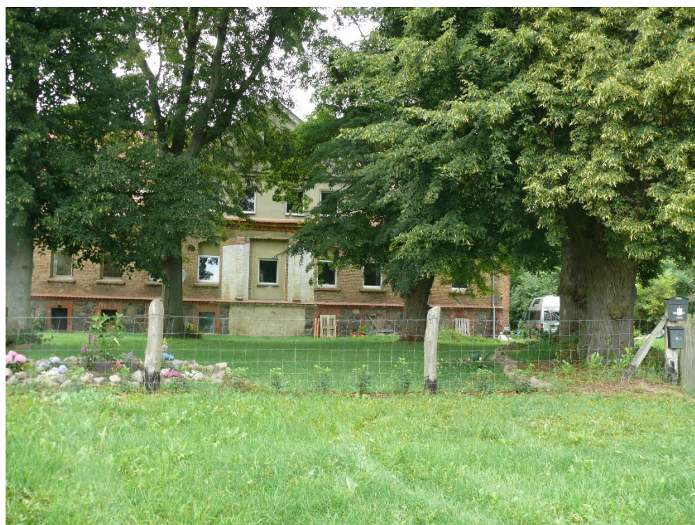
Foto IP 07, Thurow, Ringstr. 19/20/21 Blick von Südosten
