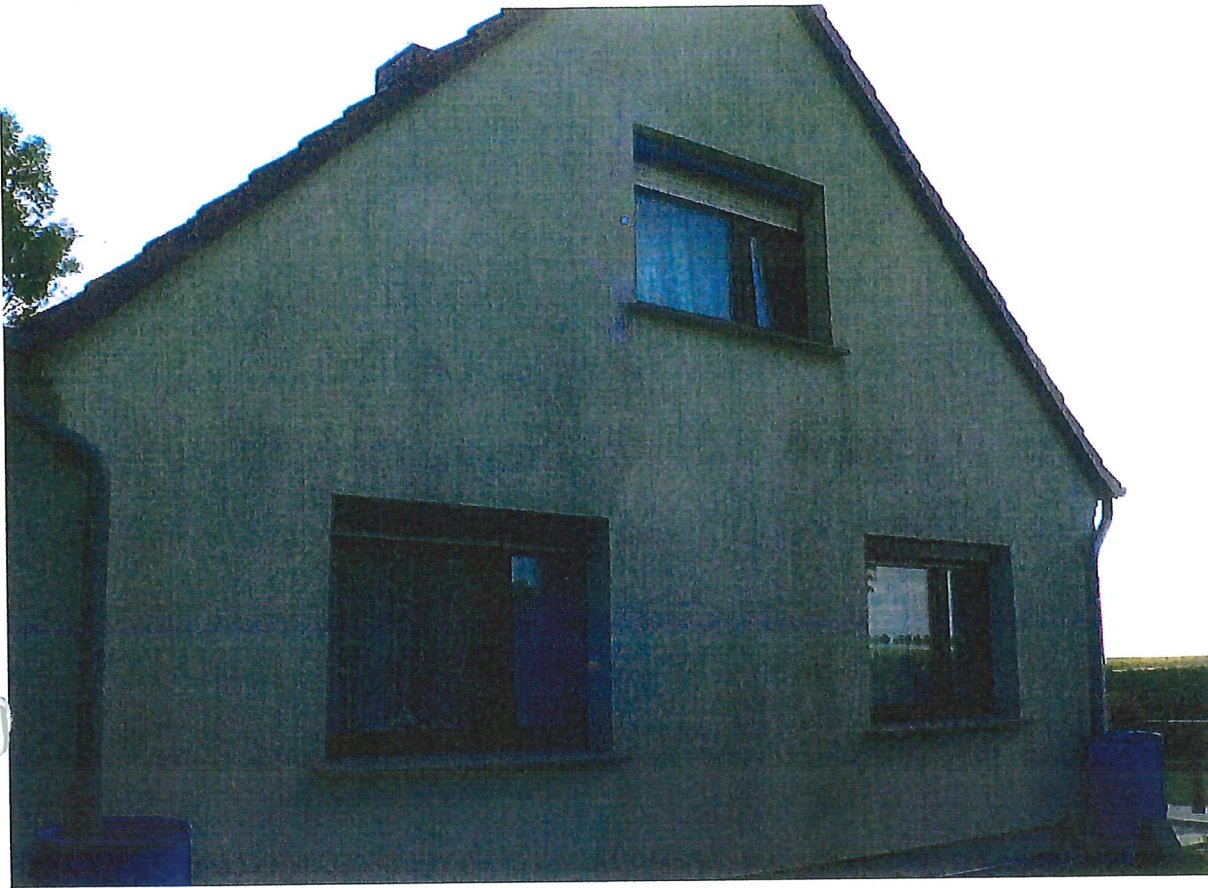
Bild „Westgiebel“ zeigt rechts zweites Fenster Wohnzimmer, Fenster Schlafzimmer und im Dachgeschoss Fenster von Kinderzimmer [redacted] keine direkte Sicht auf Windpark Miltzow und Neu-WEA03
