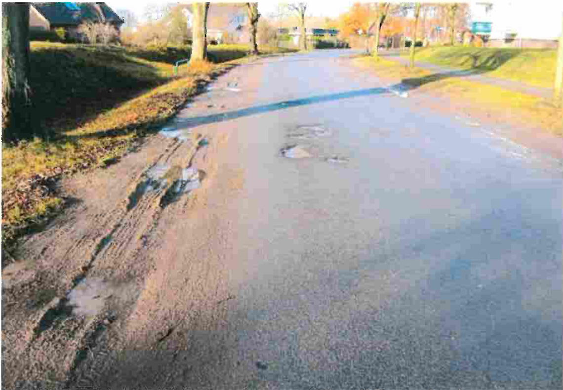
Bild 3: Fahrbahnoberfläche der K 18 OD Warnow Höhe Entnahmestelle 4 Oberflächenverbesserung durch dünne Asphaltsschicht auf Pflaster Bankettbereiche ausgefahren
