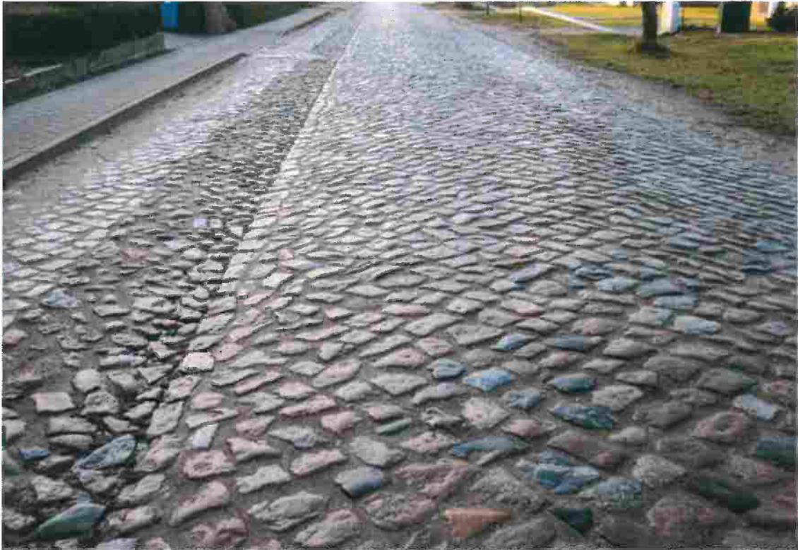
Bild 1: Fahrbahnoberfläche der K 18 OD Warnow Höhe Entnahmestelle 1 am Bauanfang
