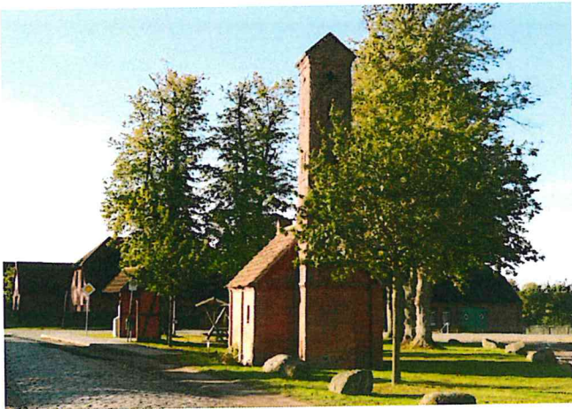
Abb.1: Bereich Seehagen Abzweig Dorfstraße mit Bushaltestelle (westl. Seite 9)
