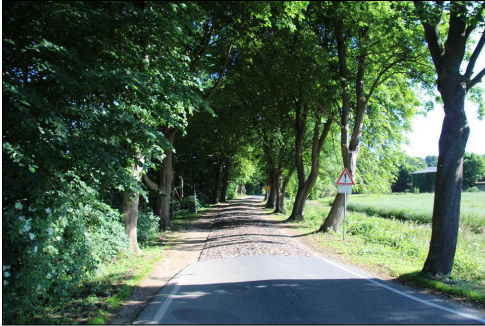
Abbildung 1: Baumbestand am Baubeginn an der K 18
