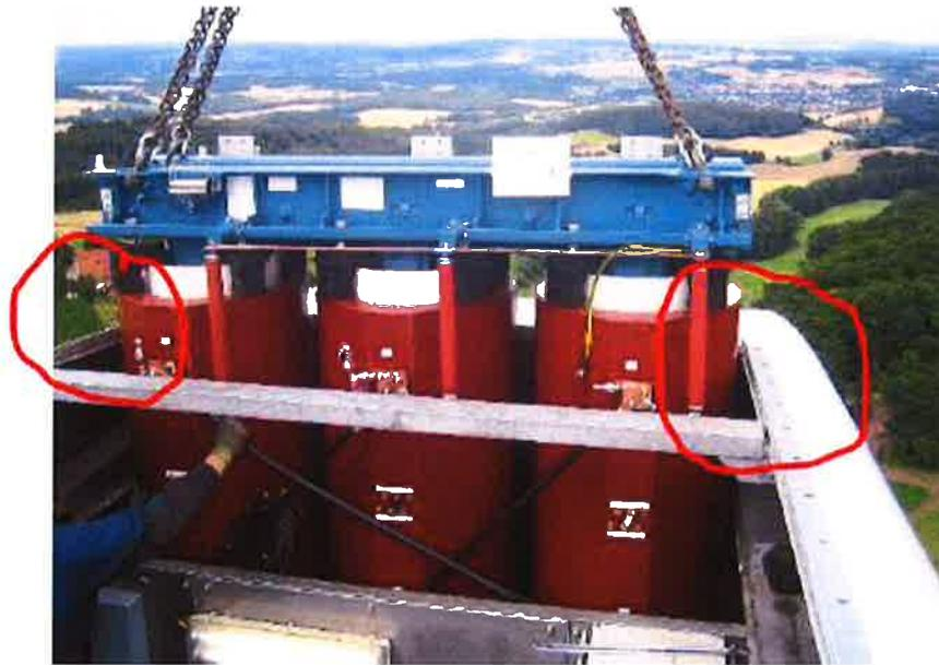
Abbildung 19-1: Führen des Transformators in das Maschinenhaus
