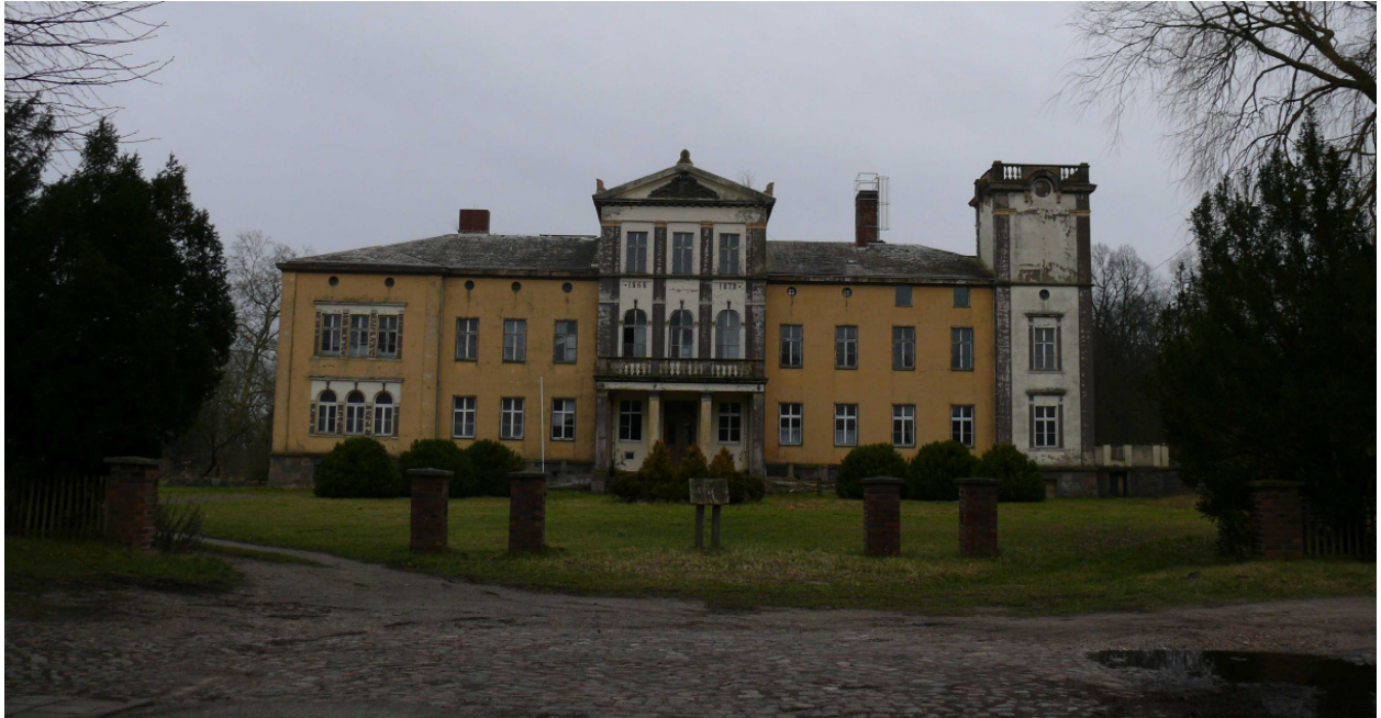
Abbildung 50: Blick auf das Herrenhaus Gültz von der Dorfseite von NW nach SO, Foto: STADT LAND FLUSS 13.01.2014.
