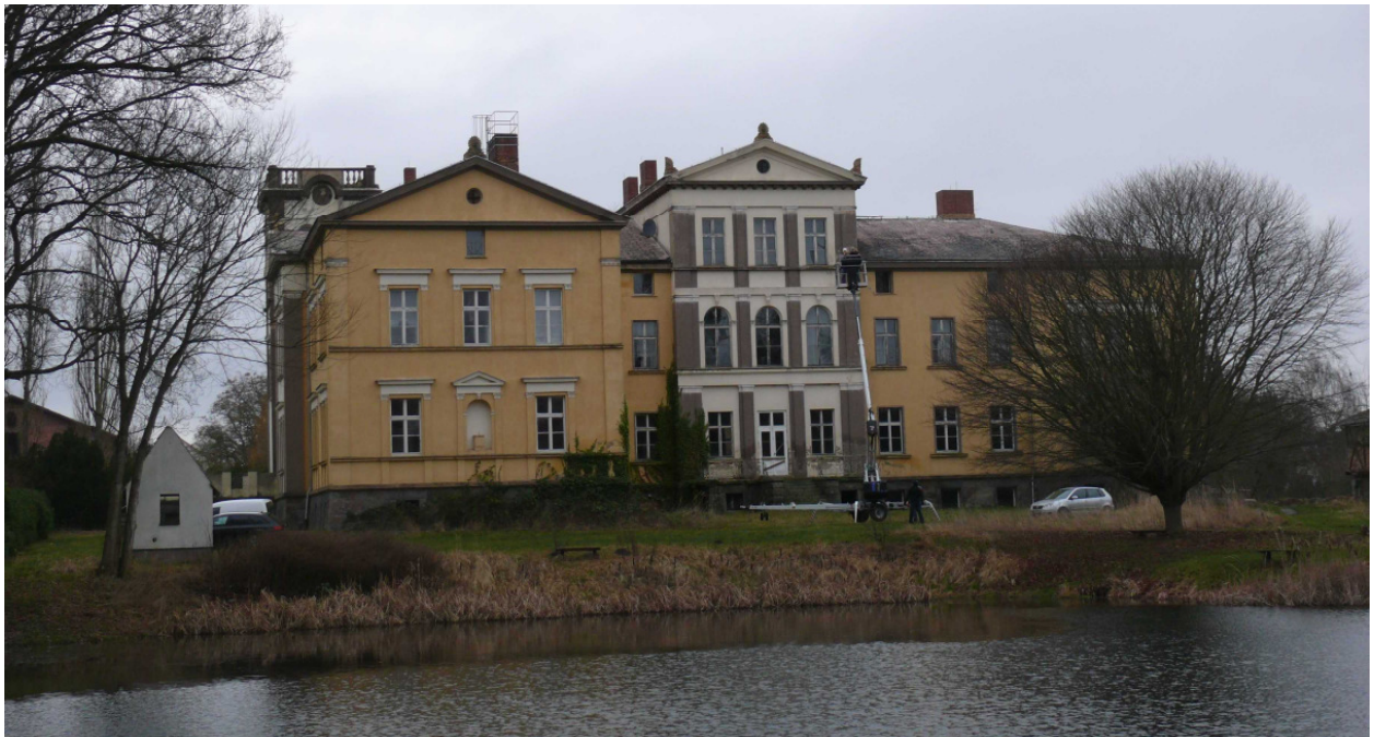
Abbildung 51: Blick auf das Gutshaus Gültz parkseitig von Südost, Foto: STADT LAND FLUSS 13.01.2014.
