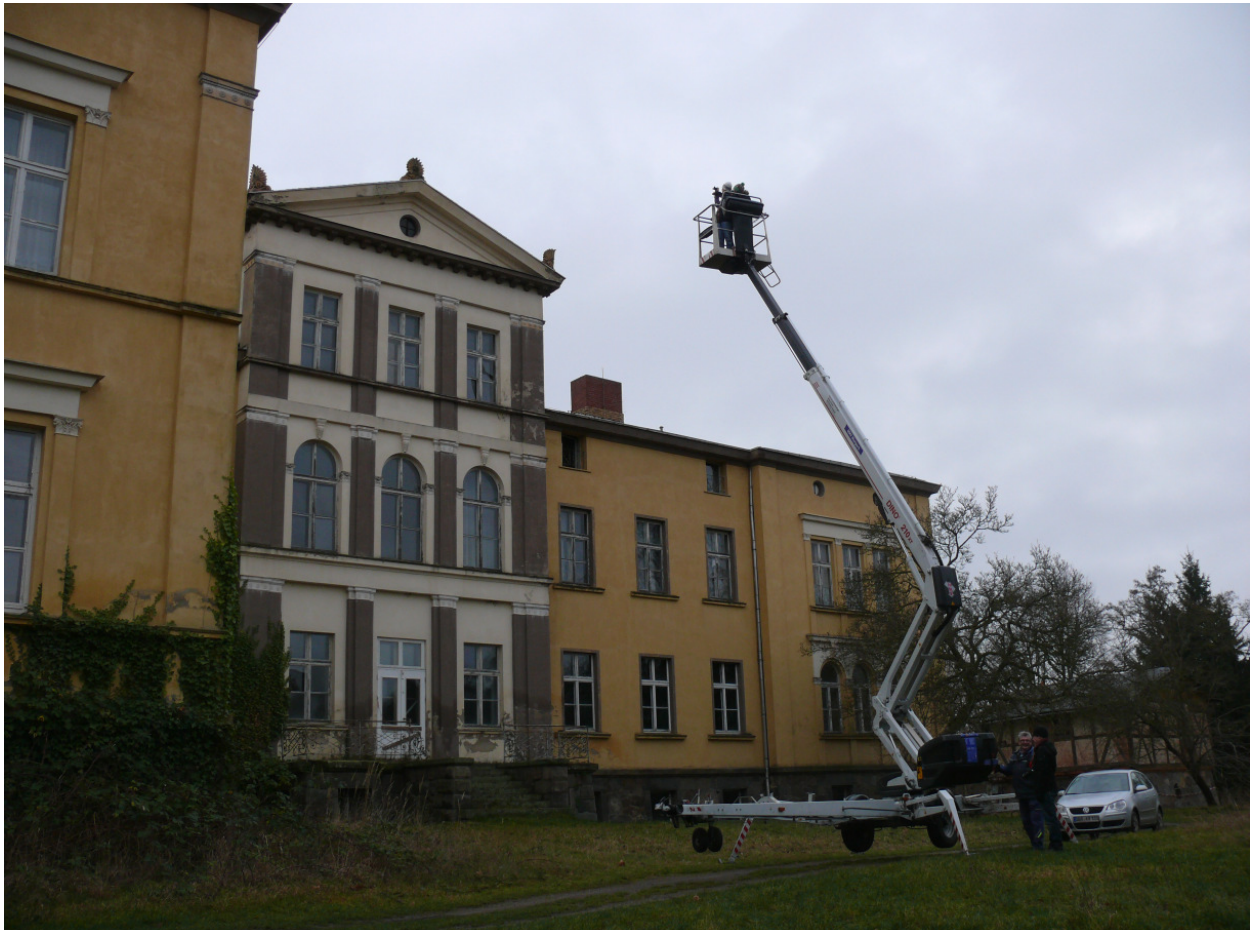
Abbildung 1: Der Einsatz eines Hubsteigers ermöglichte die Nachvollziehbarkeit der Sichtbeziehungen und Ausblicke, die sich von den oberen Fensterebenen der derzeit nicht begehbaren Gebäude bieten. Foto: SLF 13.01.2014.
