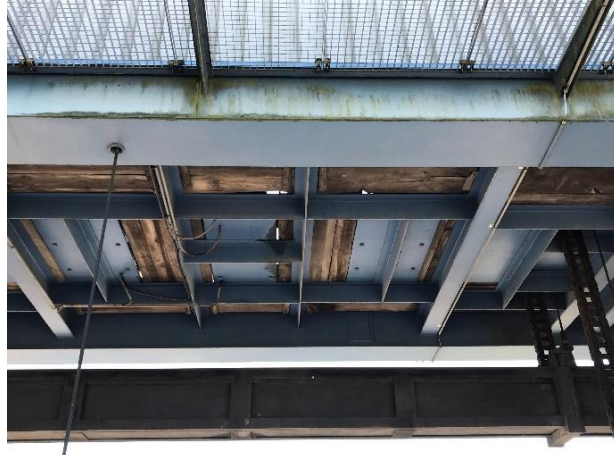
Abbildung 44: Einflugmöglichkeiten in den Innenraum des Gebäudes
