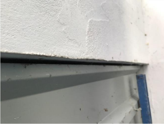
Abbildung 41: Pot. Spaltenquartiere zwischen Blechverkleidung und Mauerwerk (Innenraum)
