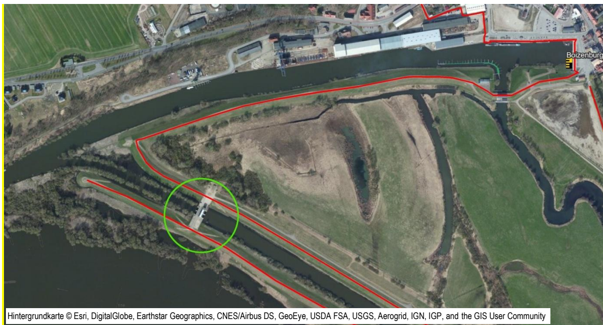
Abbildung 1.1: Orthobild des Abschlussbauwerks der Sude im Istzustand (grüne Markierung)
