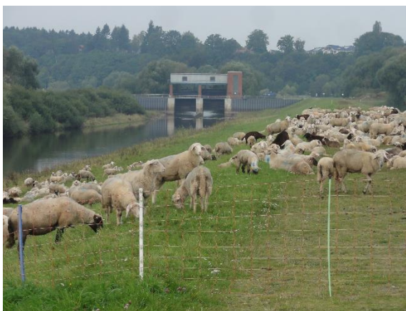
Abbildung 4-5: Schafbeweidung des Rechten Sudedeiches Boizenburg, Sudeabschlussbauwerk, dahinter Steilufer OT Vier (25.09.2017)
