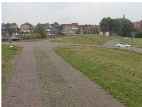
Abbildung 4-2: Hafendeich östlich des Schöpfwerkes (25.09.2017)
