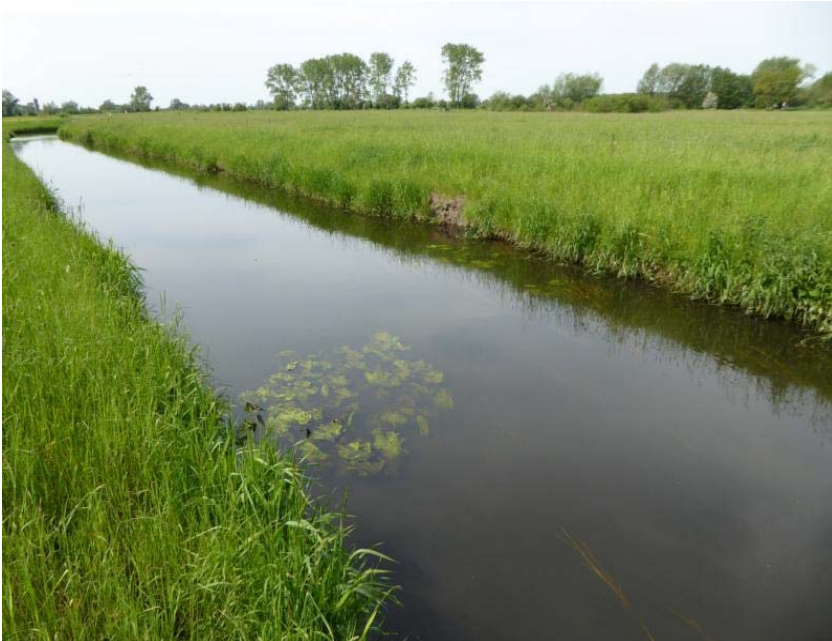
Abbildung 9 Ausgebauter Bach, der von Norden in das Gebiet fließt.
