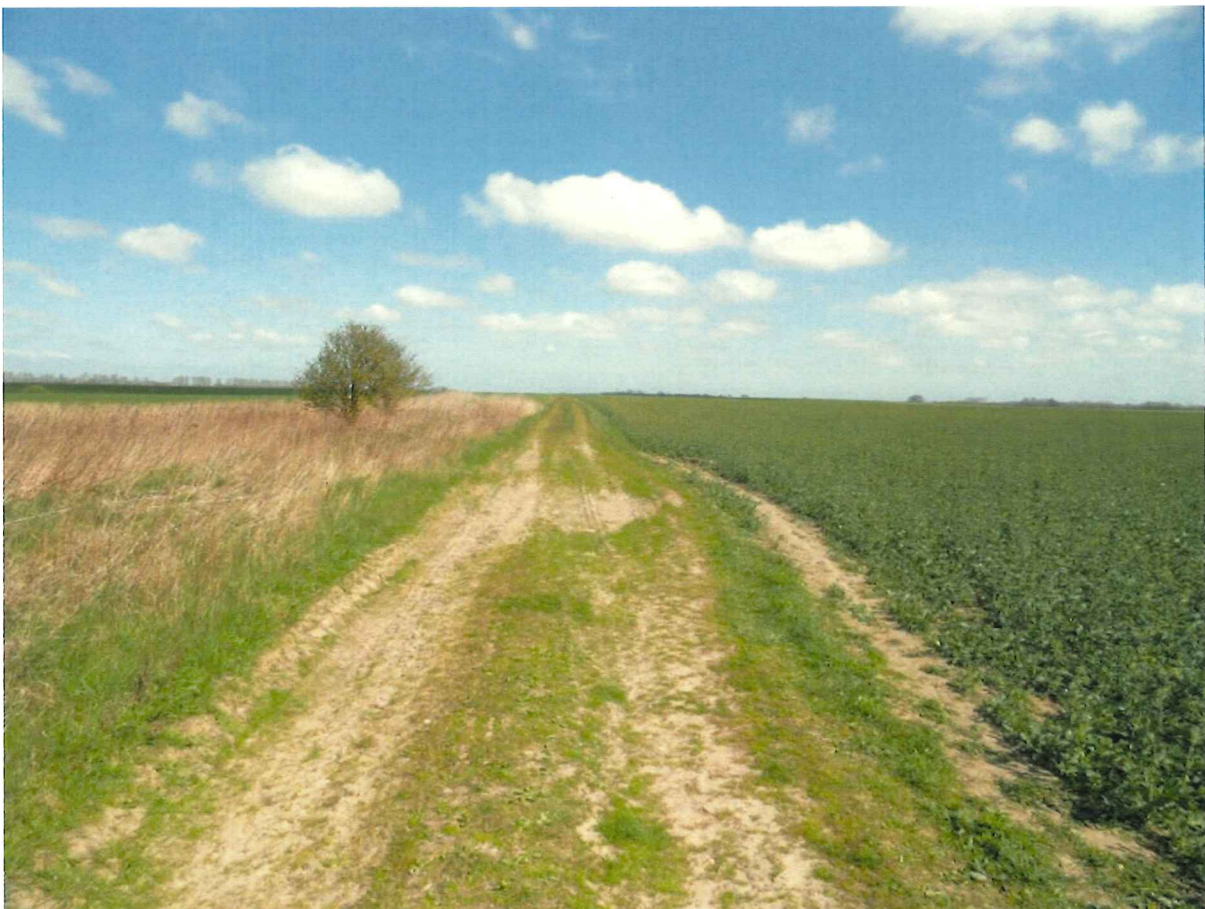
0+1600 in Richtung Bauanfang
