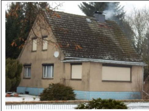
Bild 41: IO 68, Friedrichsruhe Hof, Hauptstraße 33
