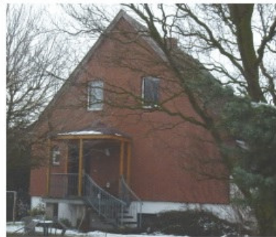
Bild 36: IO 60, Friedrichsruhe Hof, Hauptstraße 43
