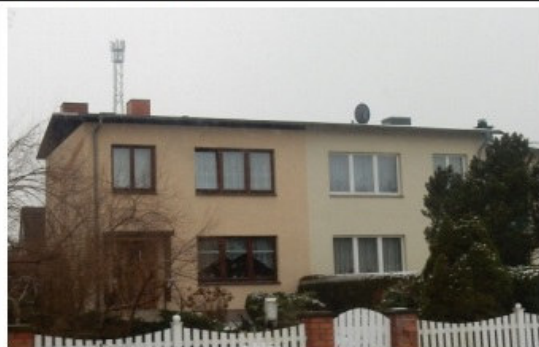
Bild 47: IO 74, Friedrichsruhe Hof, Hauptstraße 14/15
