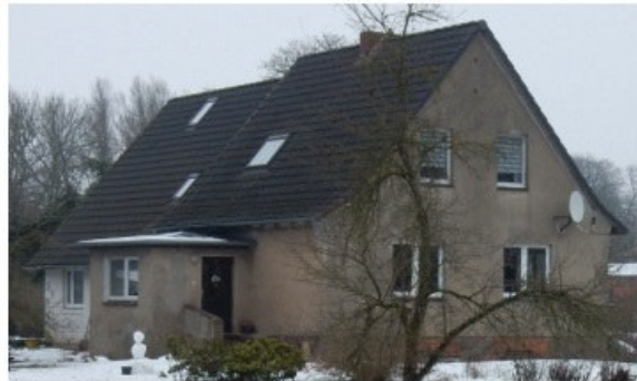
Bild 43: IO 70, Friedrichsruhe Hof, Hauptstraße 31
