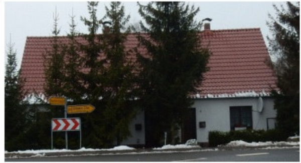
Bild 34: IO 58, Friedrichsruhe Hof, Hauptstraße 6/7
