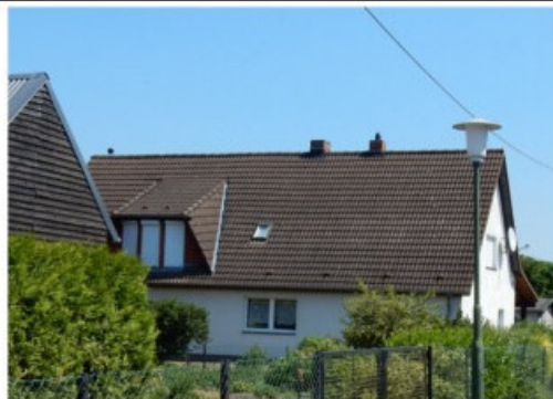
Bild 138: IO 211, Severin, Domsühler Str. 13
