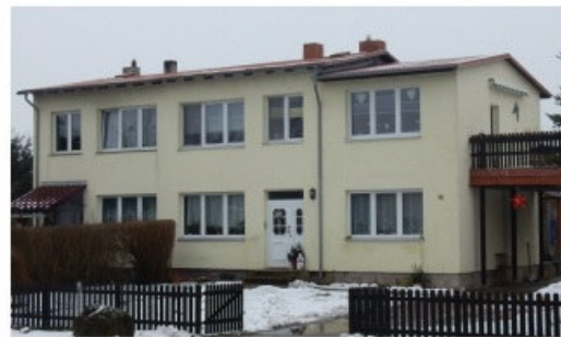
Bild 46: IO 73, Friedrichsruhe Hof, Hauptstraße 12/13
