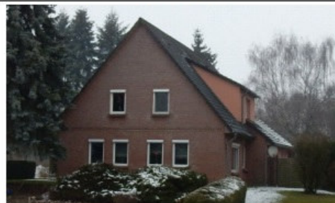
Bild 40: IO 67, Friedrichsruhe Hof, Hauptstraße 34
