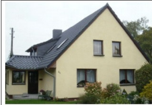
Bild 57: IO 86, Friedrichsruhe Hof, Hauptstraße 24
