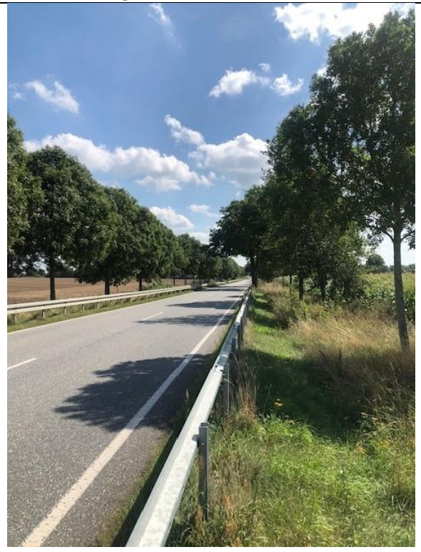
Blick nach Südost mit B321.
