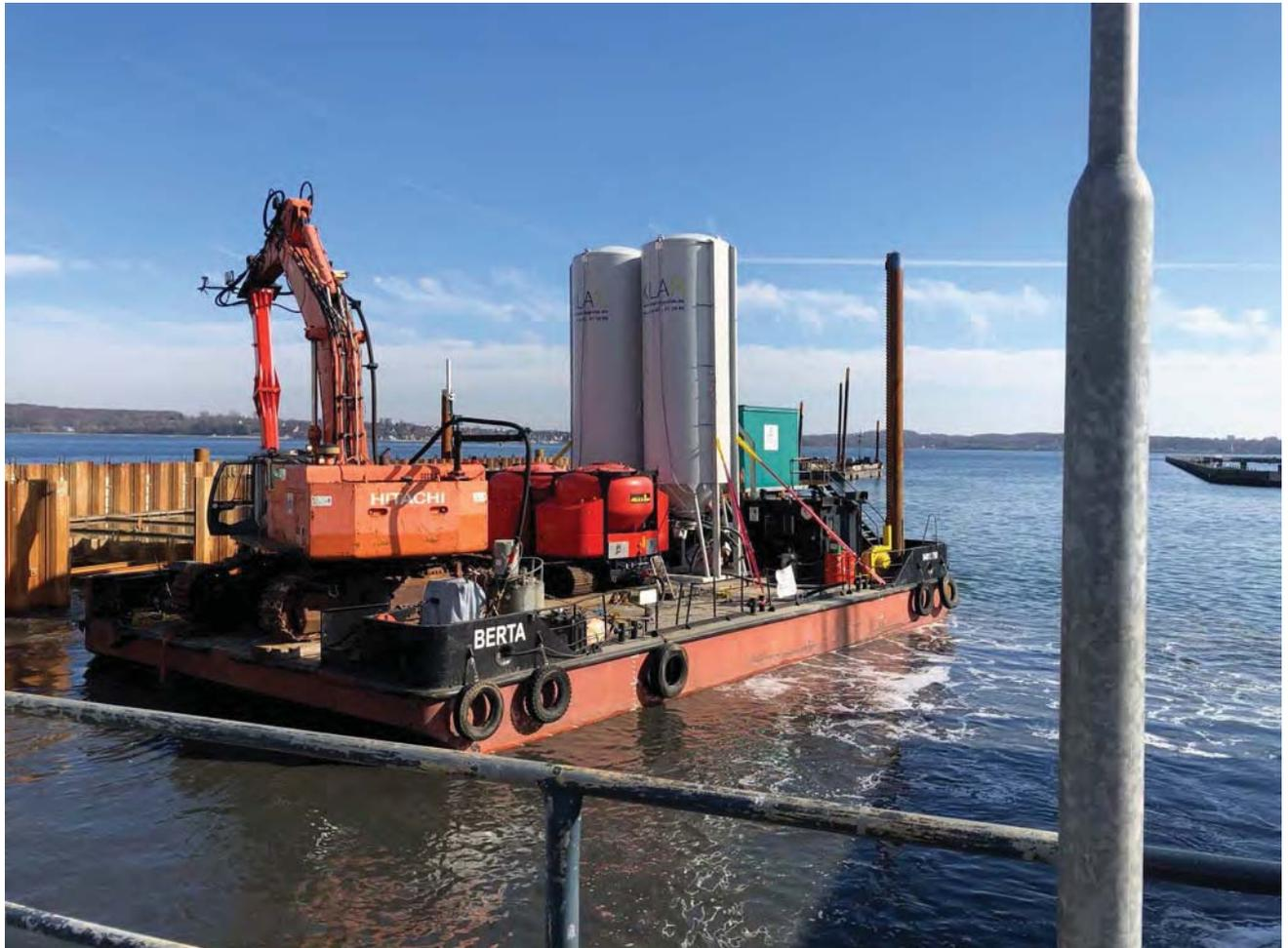
*Abbildung 10 Ponton Berta in Kiel bei GF Werft beim Bodenkonditionieren*
