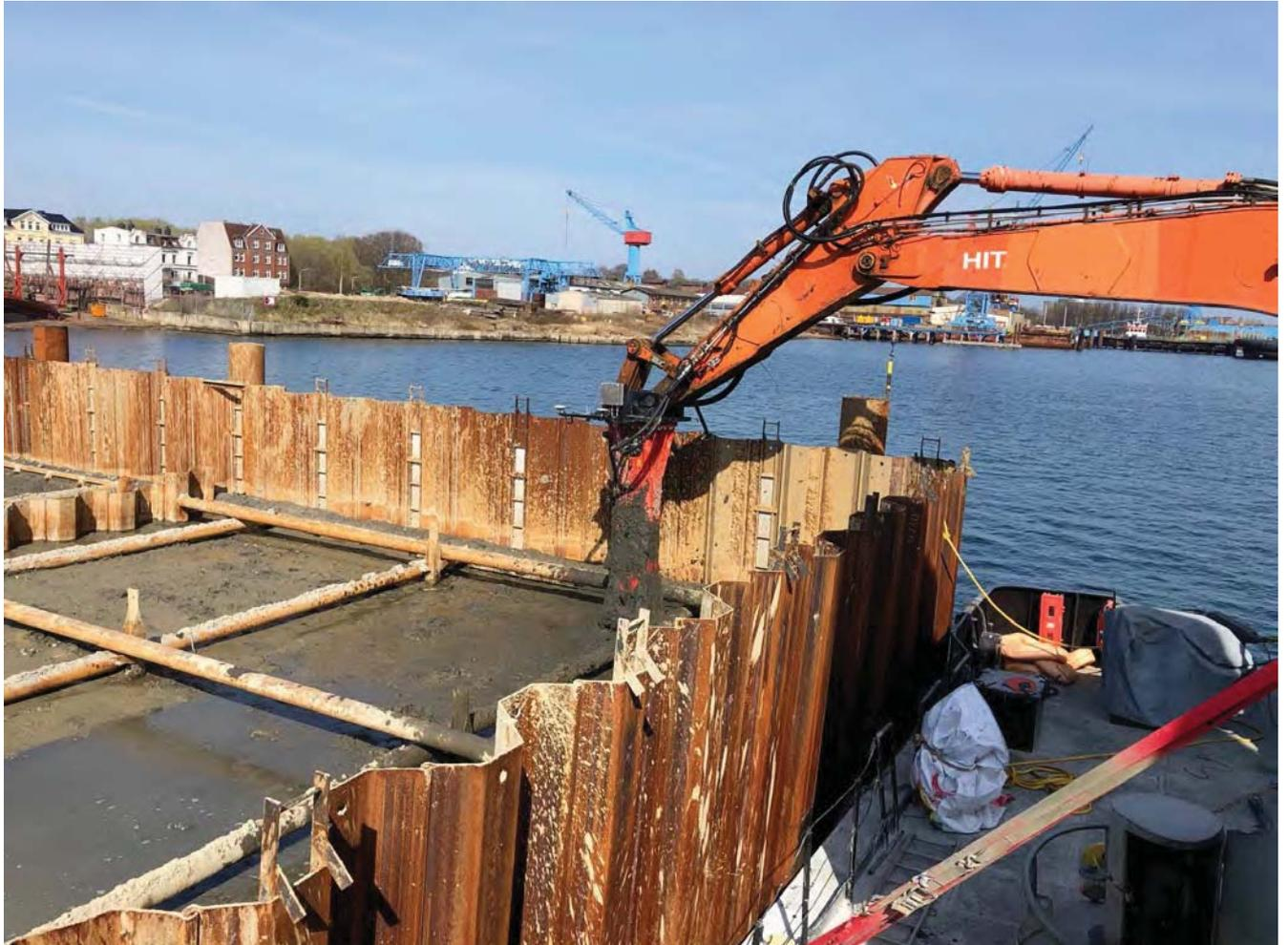
*Abbildung 11 Ponton Berta beim Konditionieren von Baggergut mit Zement in Kiel GF Werft*
