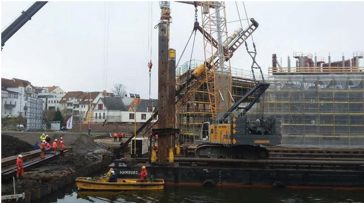
Stelzenponton MC 51 bei der Schrägpfahlrammung
