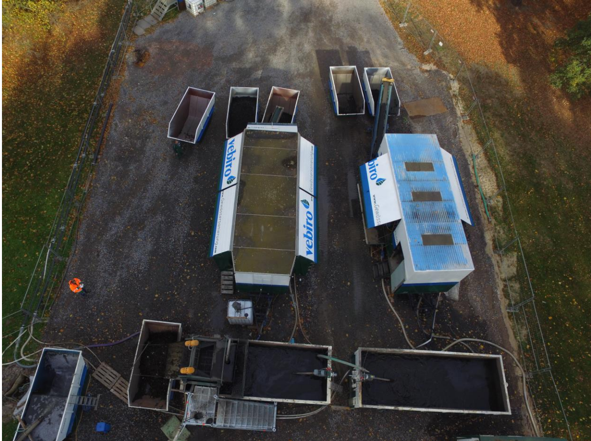
Mobile Schlammaufbereitungsanlage im Einsatz
