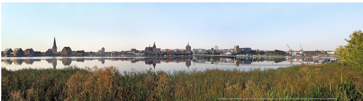
Abbildung 28: Standpunkt 3 der Fotosimulation – Östliche Hechtgrabenbrücke
