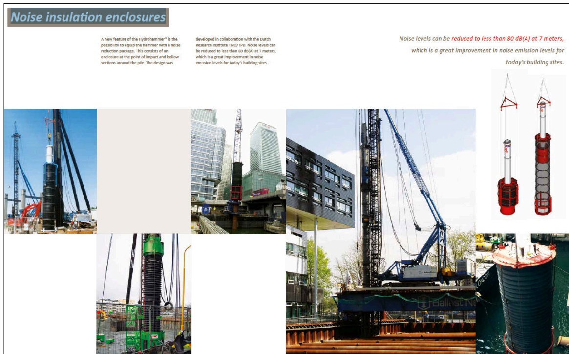
Abbildung 2: Schallschutzkamin zur Verringerung der Rammgeräuschimmission [46]
