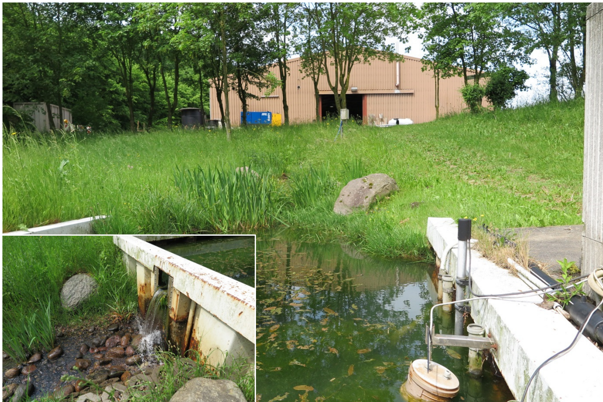
Abbildung 3-1: Sammelbecken für Permeat; Bild unten links: Probenahmestelle 1.
