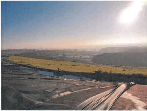
Blick vom Deponiekörper (Altteil) in Richtung Ost
