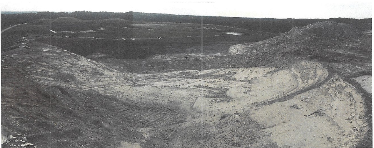
Abb. 2: Ablagerung auf der Böschung im BA 8, oberes und unteres Niveau (September 2020)
