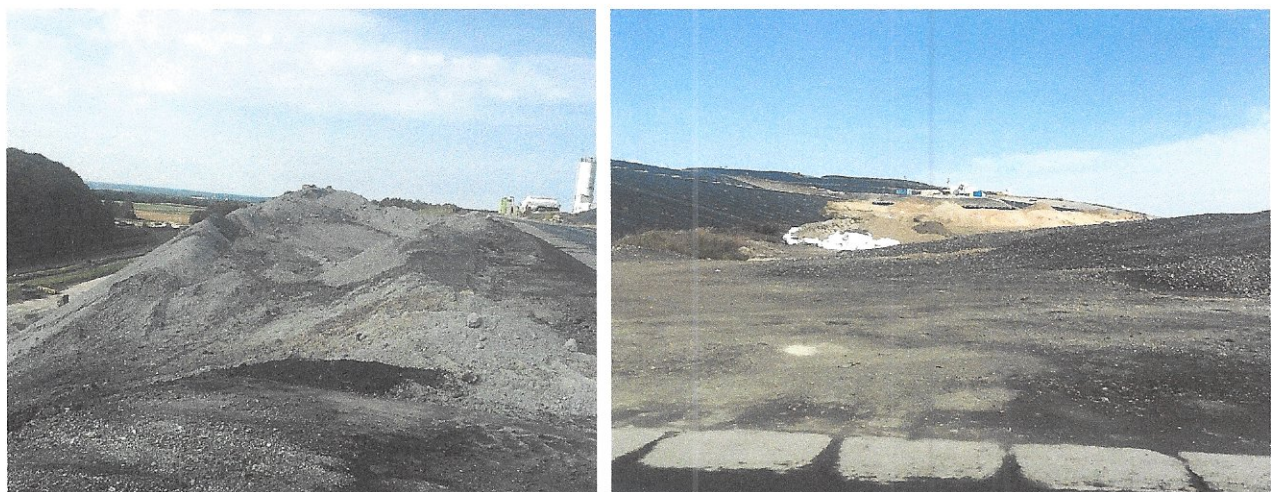
Abb. 5: Randdamm / Böschung 1. und 2. BA-MFA BF West (September 2020)
