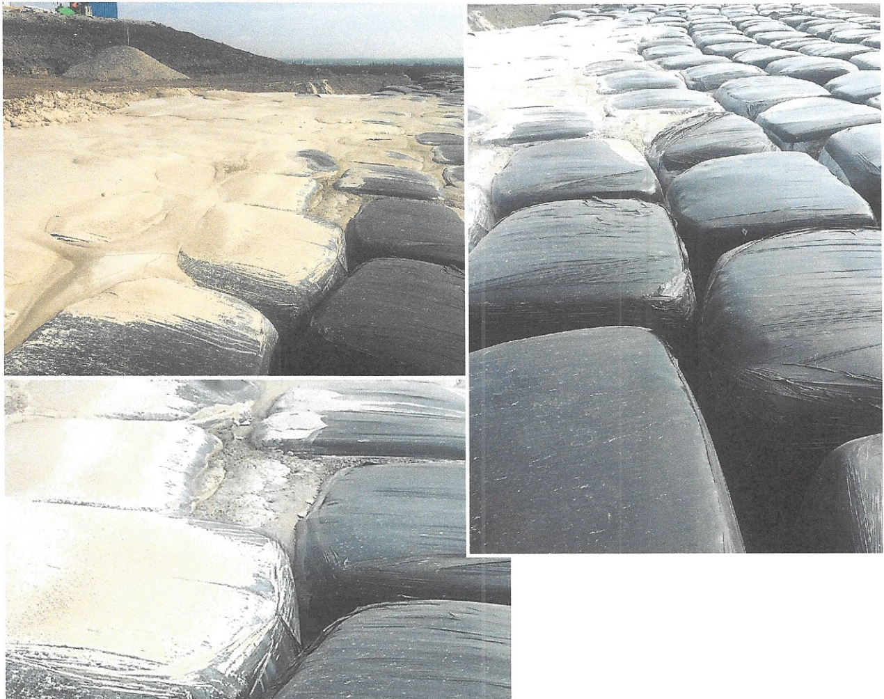
Abb. 7: Komprimierte, verpackte und in den Ballenfugen vergossene KMF- Ablagerung im 2. BA-MFA Baufeld Nord und 3. BA MFA (September 2020)
