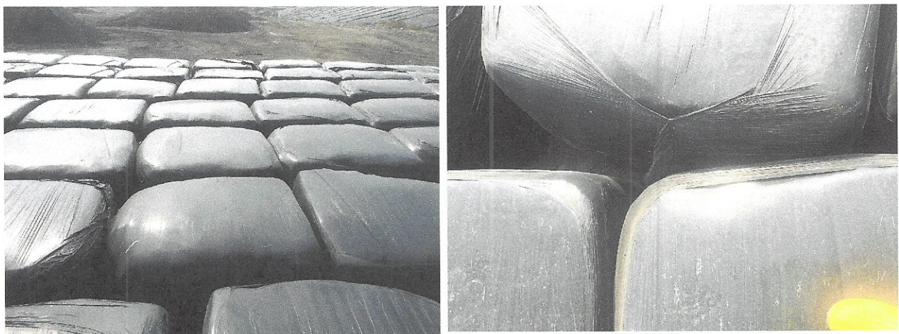
Abb. 6: Einbaufläche im 2.BA-MFA Baufeld Nord und 3. BA-MFA mit komprimierten KMF- Ballen (September 2020)
