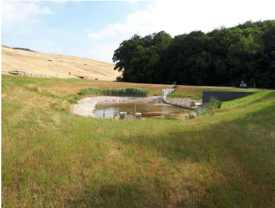
Abbildung 7: Regenbecken 6, Juni 2018 (Blickrichtung Nordosten)
