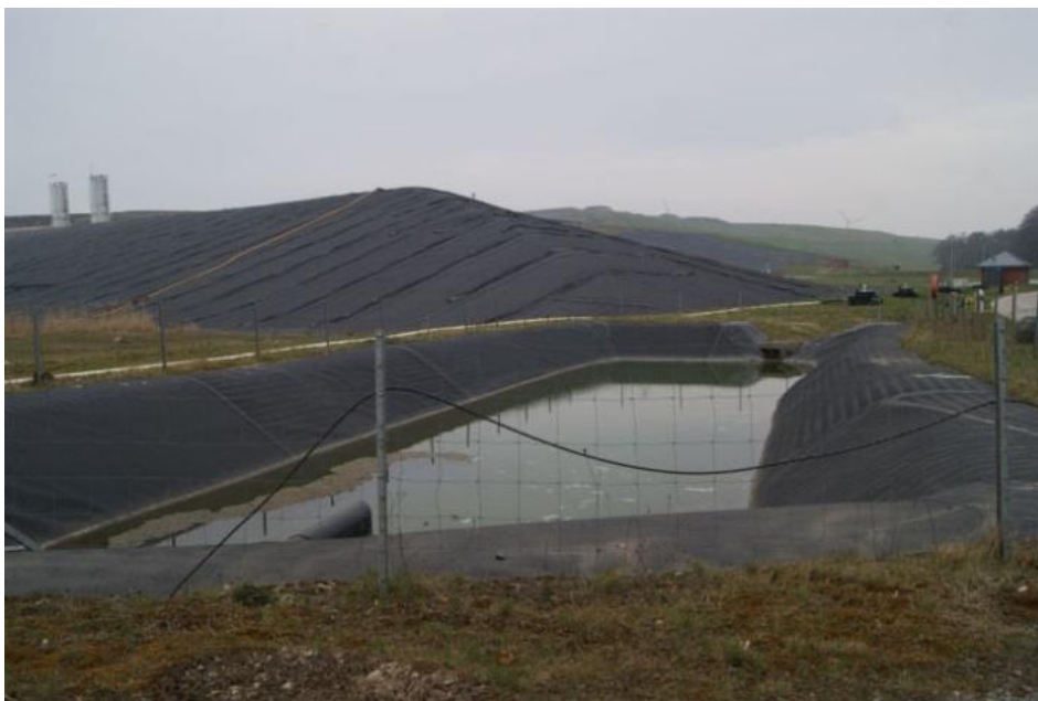
Abbildung 5: Regenbecken 4, April 2018 (Blickrichtung Norden)
