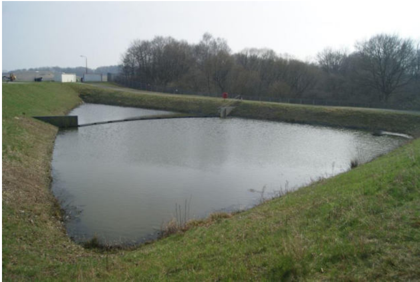
Abbildung 2 – Regenbecken 1 (RHB West) im April 2018 (Blickrichtung Süden)
