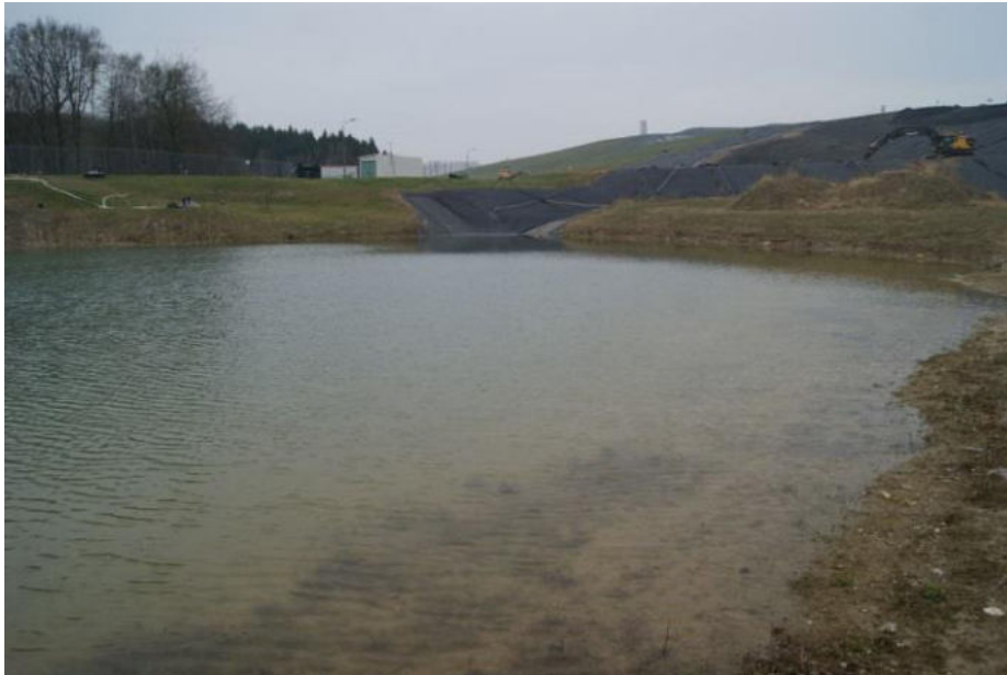
Abbildung 3 - Regenbecken 2 im April 2018 (Blickrichtung Norden)
