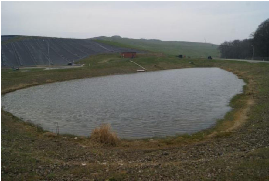
Abbildung 6: Regenbecken 5, April 2018 (Blickrichtung Nordosten)
