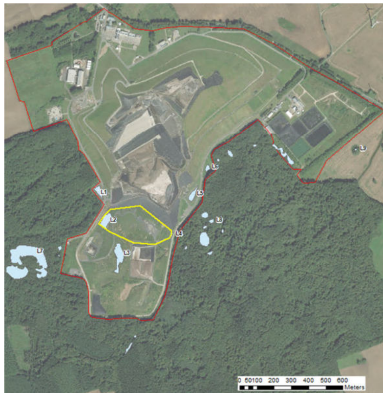
Abbildung 1 - Übersicht der Deponie Ihlenberg (gelb = BA 7/8 Süd, hellblau = Gewässer/Regenrückhaltebecken im südl. Bereich mit Nr.)
