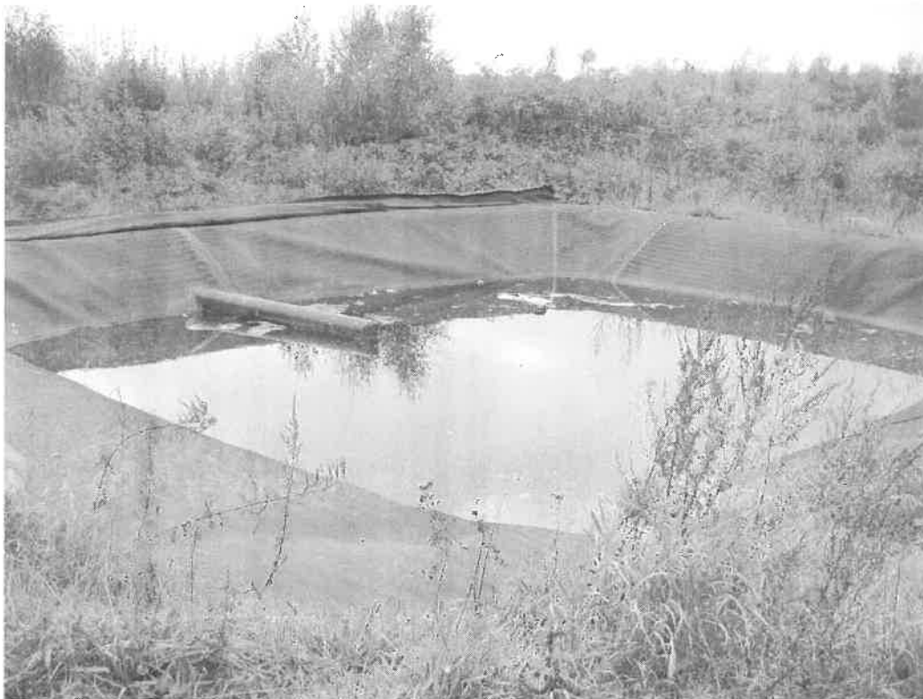
Abb. 2.6: Speicherbecken Niederschlagswasser Ost mit Überlauf
