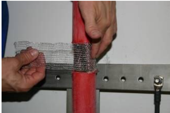
Abbildung 7-7: Kupfergeflecht wird rundherum gewickelt
