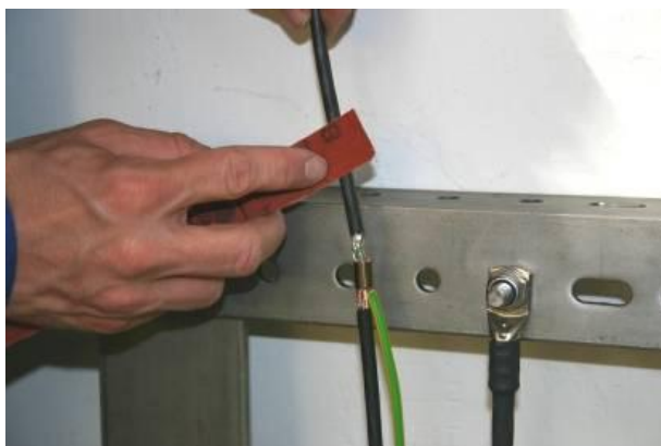
Abbildung 7-30: Vorbereiten der Isolierung zum Aufbringen des Warmschrumpfschlauches
