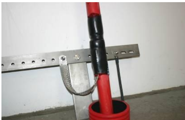
Abbildung 7-20: Vollständig montierte Kupferlitze
