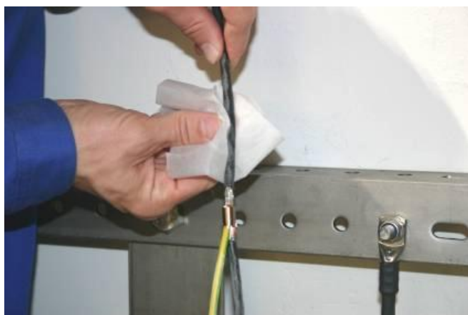
Abbildung 7-31: Reinigen der vorbereiteten Isolierungsfläche
