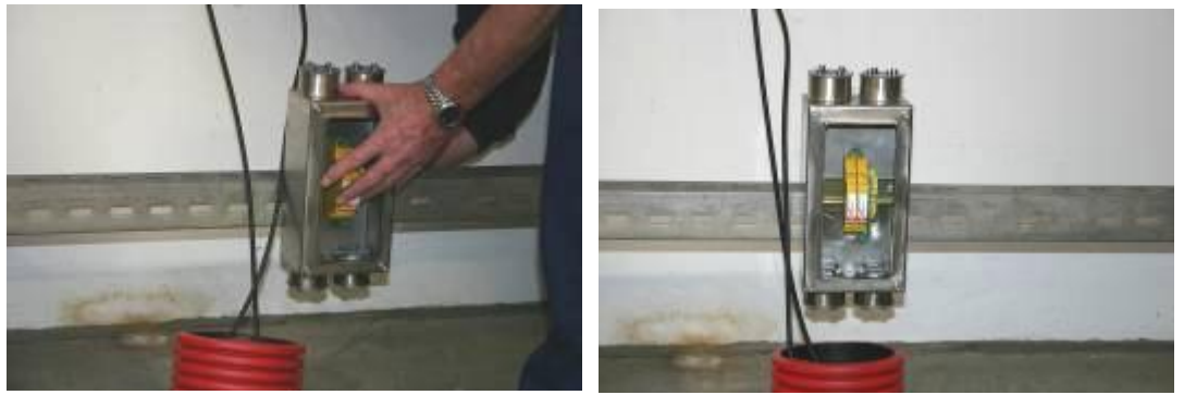
Abbildung 7-41: Potentialausgleichskasten an der Haupterdungsschiene
