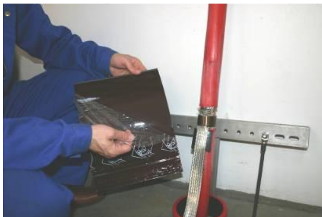
Abbildung 7-14: Entfernen der Schutzfolie
