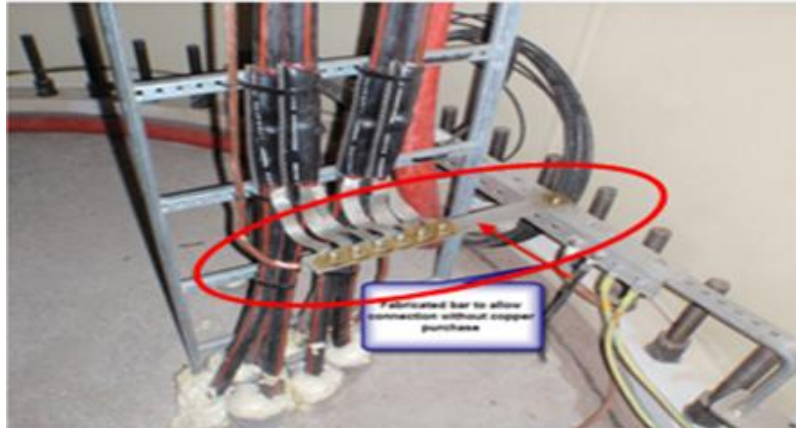
Abbildung 7-21: Erweiterung der Haupterdungsschiene
