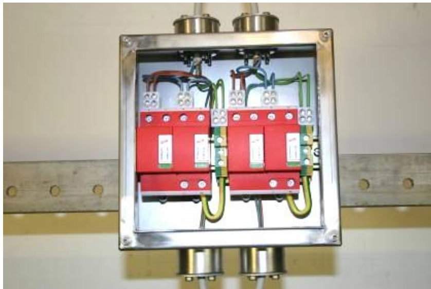
Abbildung 7-60: Ordnungsgemäßer Anschluss aller Leitungen
