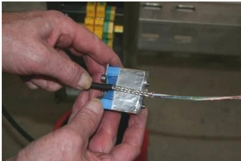
Abbildung 7-42: Entfernung der Kabelisolierung und Anpassen des Metallkabelmantels für EMV/PE-Dichtungsmodule
