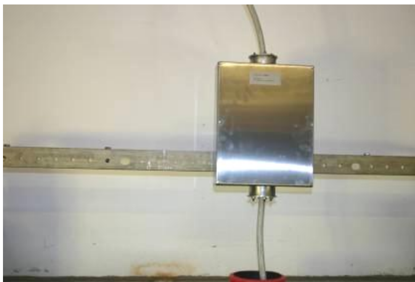
Abbildung 7-70: Angebrachte Abdeckung nach fertiger Installation
