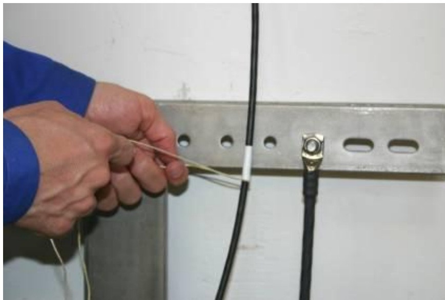
Abbildung 7-24: Schneiden der Kabelisolierung mit einer Schneide-/Kevlarkordel
