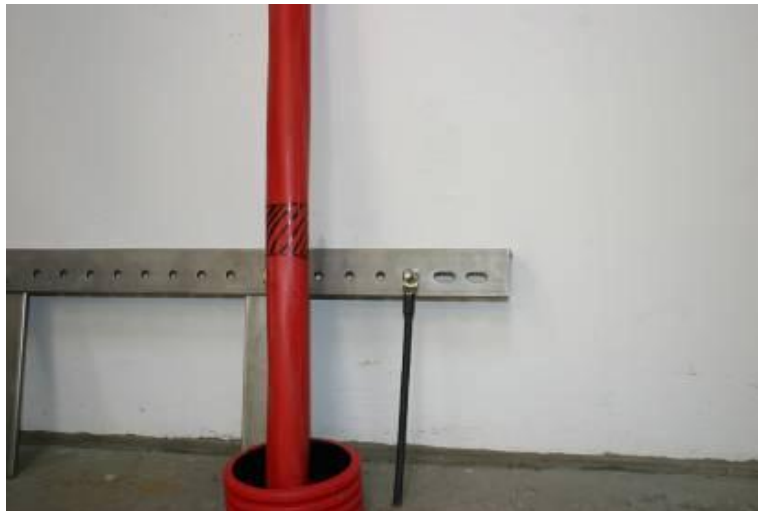
Abbildung 7-2: Hauptenergiekabel mit gekennzeichneteter Fläche, in der die Kabelisolierung herausgeschnitten werden muss
