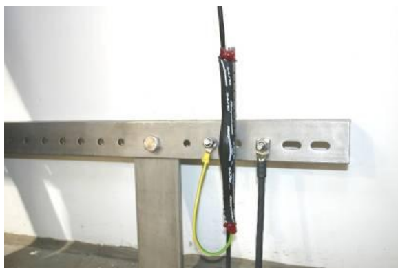
Abbildung 7-39: Fertig montierter Verbindungsdraht
