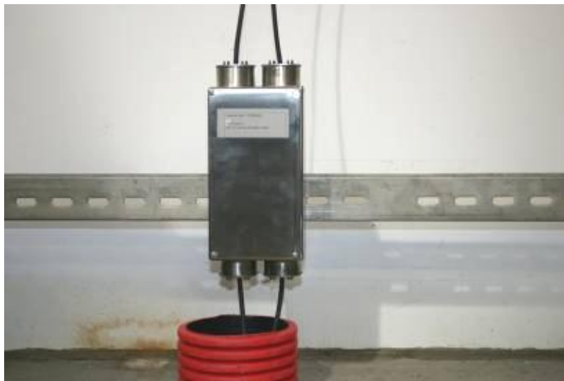
Abbildung 7-53: Angebrachte Abdeckung nach fertiger Installation
