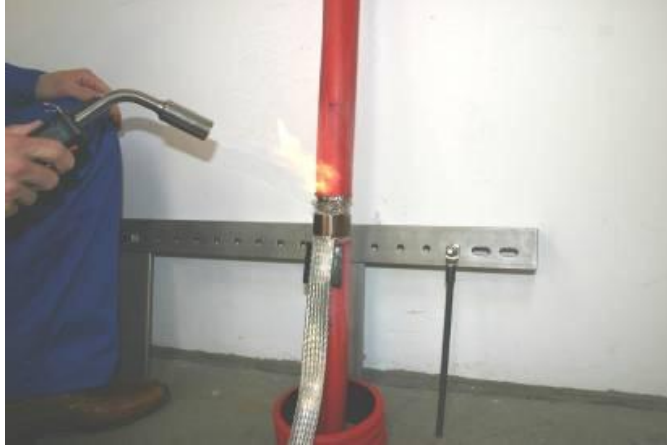
Abbildung 7-15: Vorwärmen der Kabelisolierung
