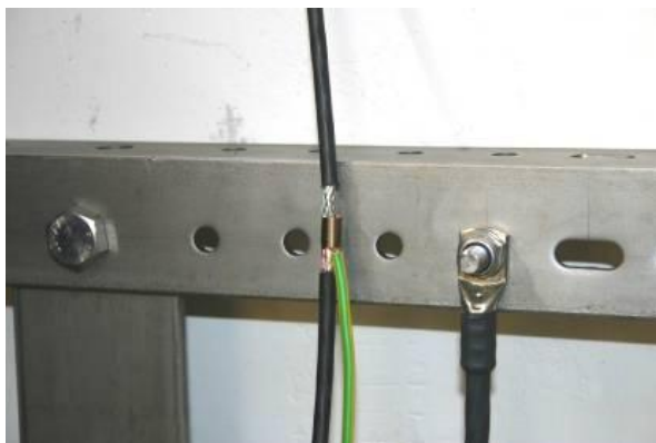
Abbildung 7-29: Kabel mit montierter Verbindungsfeder und Verbindungsdraht
