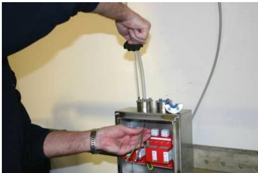
Abbildung 7-58: Festziehen der Schrauben am Dichtungskeil
