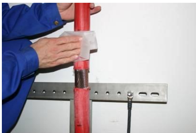
Abbildung 7-6: Reinigen der vorbereiteten Isolierfläche
