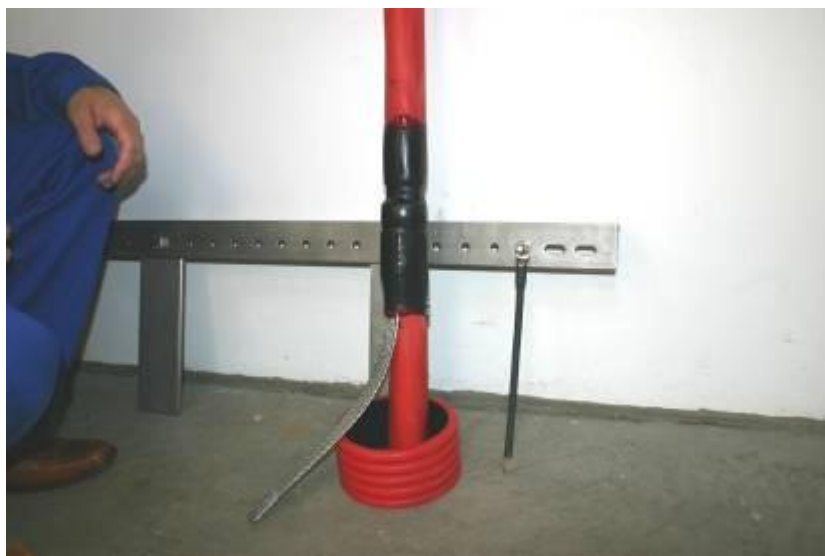
Abbildung 7-19: Fertig montierter Warmschrumpfschlauch
