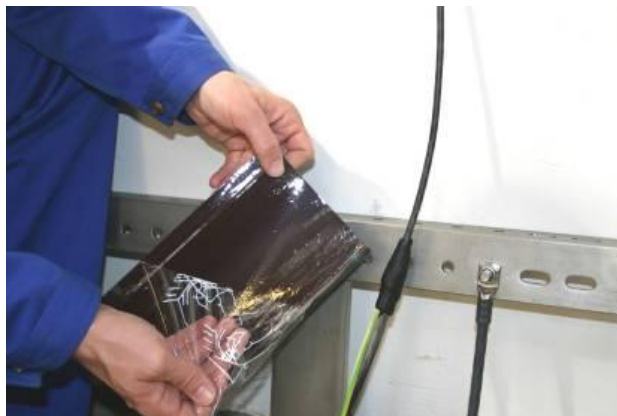
Abbildung 7-34: Entfernen der Schutzfolie
