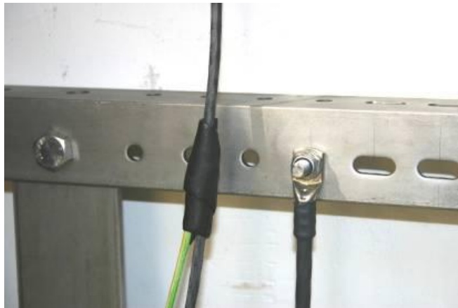
Abbildung 7-33: Um das Kabel und den Verbindungsdraht gewickelte Abdichtung
