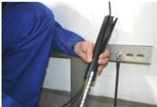
Abbildung 7-36 Den Schlauch um das Kabel wickeln
