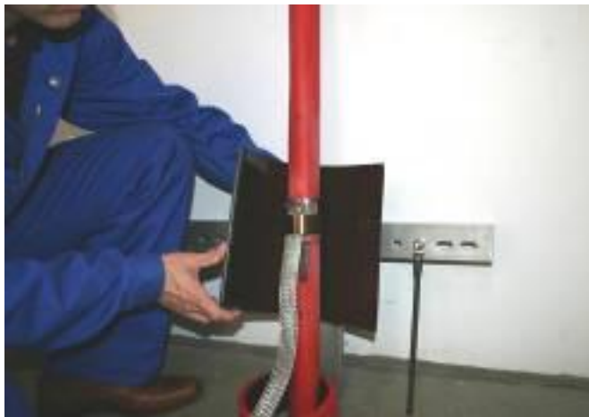
Abbildung 7-16 Anlegen des Warmschrumpfschlauches um das Kabel
