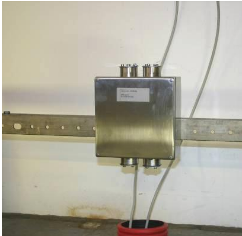
Abbildung 7-55: Potentialausgleichskasten an der Haupterdungsschiene
