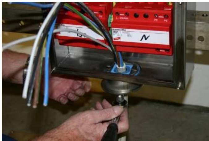
Abbildung 7-66: Ordnungsgemäßes Anbringen der Kabelisolierung und Festziehen der Schrauben am Dichtungskeil
