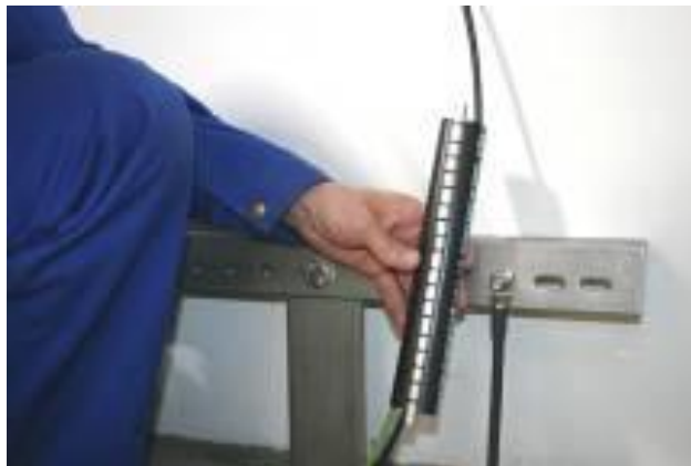
Abbildung 7-37: Einschieben der Stahlschiene
