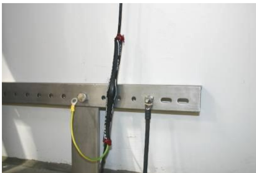
Abbildung 7-38: Fertig montierter Warmschrumpfschlauch
