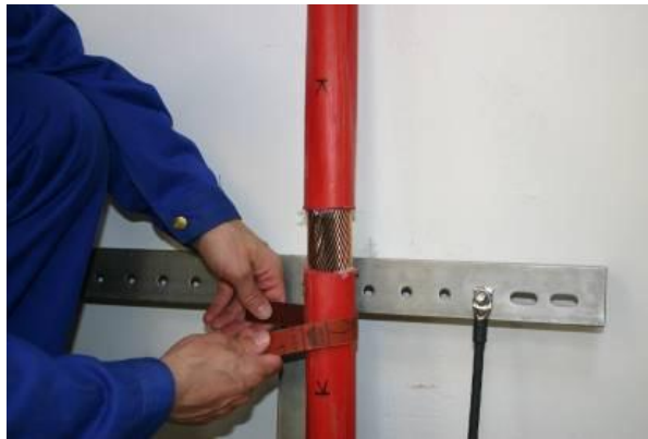
Abbildung 7-5: Vorbereiten der Isolierung zum Aufbringen des Warmschrumpfschlauches
