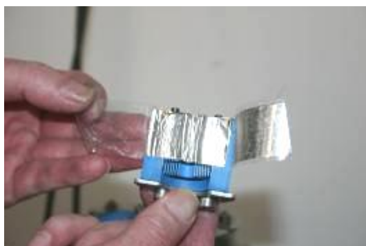
Abbildung 7-46: Abziehen des äußeren Schutzbandes
