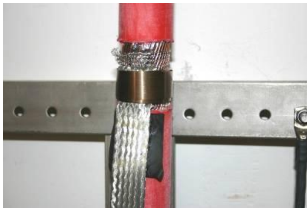
Abbildung 7-13: Unter der Kupferlitze angebrachte Abdichtung
