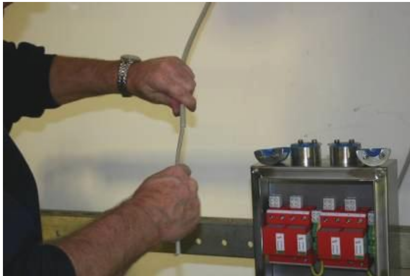
Abbildung 7-57: Entfernen der äußeren Kabelisolierung
