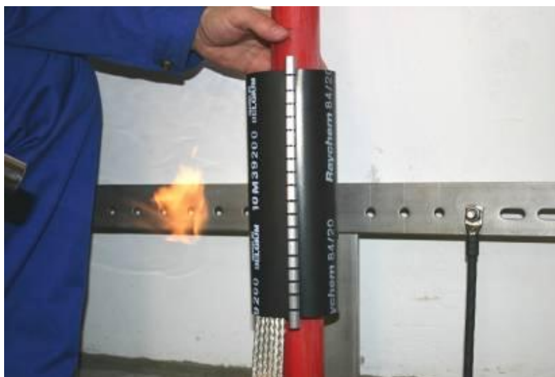
Abbildung 7-18: Erwärmen vom Schlauch mit einem Gasbrenner
