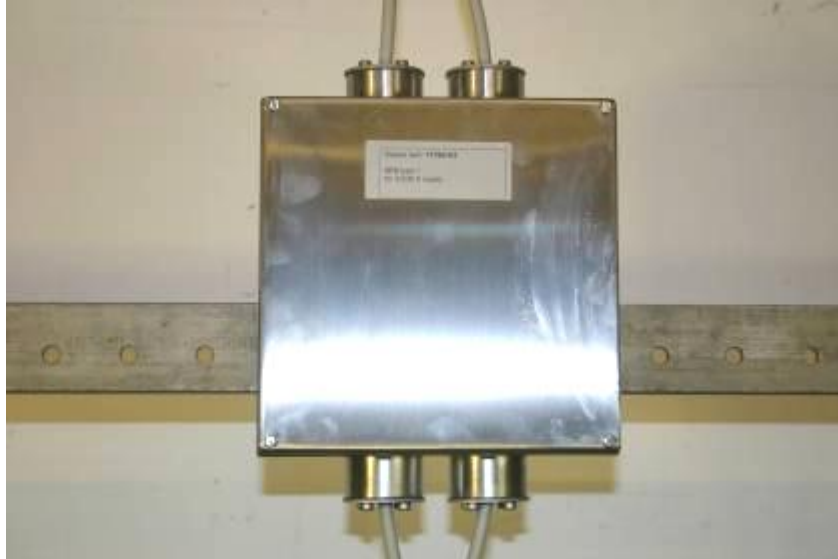
Abbildung 7-61: Angebrachte Abdeckung nach fertiger Installation
