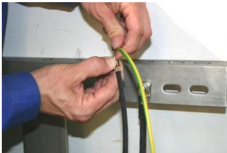
Abbildung 7-27: Eine komplette Wicklung der Verbindungsfeder um den Kabelschirm oder die Armierung
