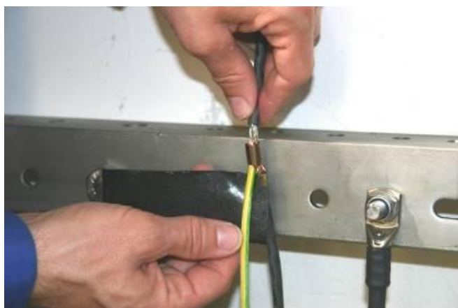
Abbildung 7-32: Angebrachte Abdichtung unter dem Verbindungsdraht
