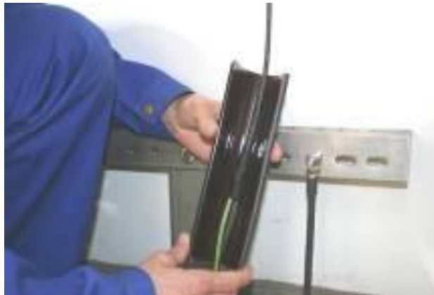
Abbildung 7-35 Einlegen des Kabels in den Warmschrumpfschlauch
