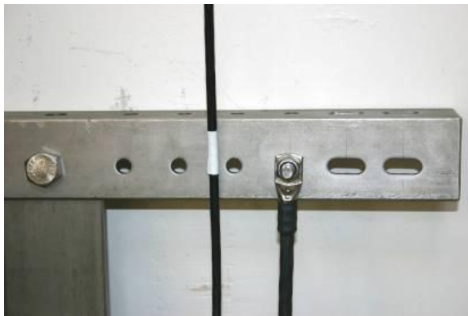
Abbildung 7-23: Hauptenergiekabel mit gekennzeichneter Fläche, an der die Kabelisolierung herausgeschnitten werden muss
