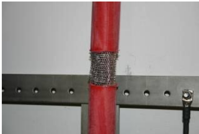
Abbildung 7-8: Angebrachtes Kupfergeflecht
