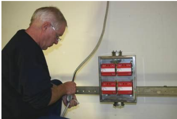
Abbildung 7-65: Entfernen der äußeren Kabelisolierung
