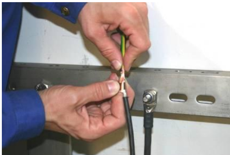
Abbildung 7-26: Am Kabel angebrachter Verbindungsdraht
