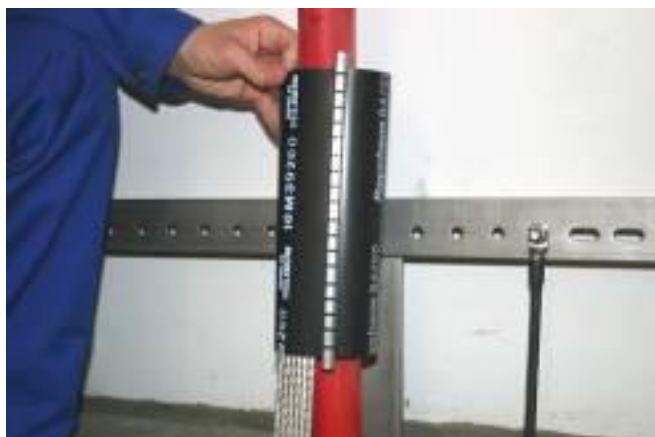
Abbildung 7-17: Angebrachter und zum Erwärmen vorbereiteter Warmschrumpfschlauch
