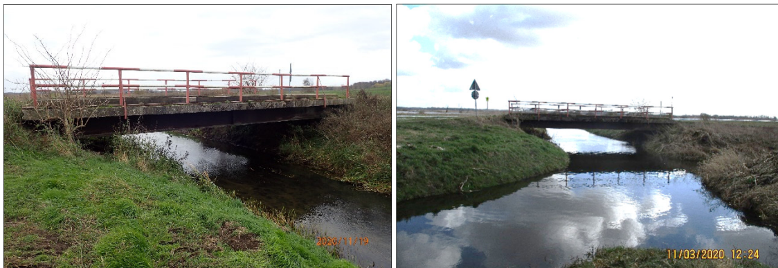
Abbildung 12: Brücke im Weg nach Levin Werder bei Station 2+280
