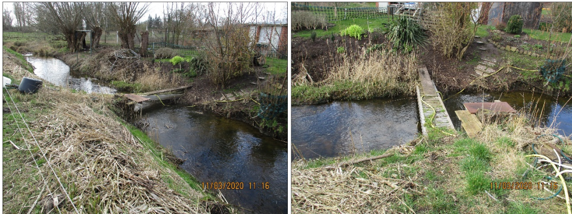
Abbildung 18: provisorischer Steg über Röcknitzbach im Bereich der Bebauung Altbauhof (Fotos März 2020)
