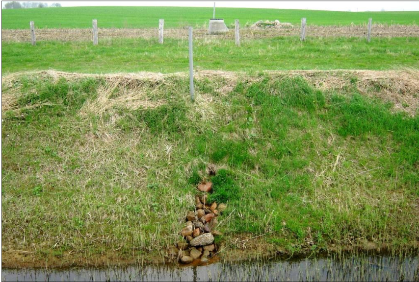
Abbildung 17: Böschungsgleich ausmündender Dränsammler - Böschungsbefestigung mit Steinpackung und Markierungspfahl
