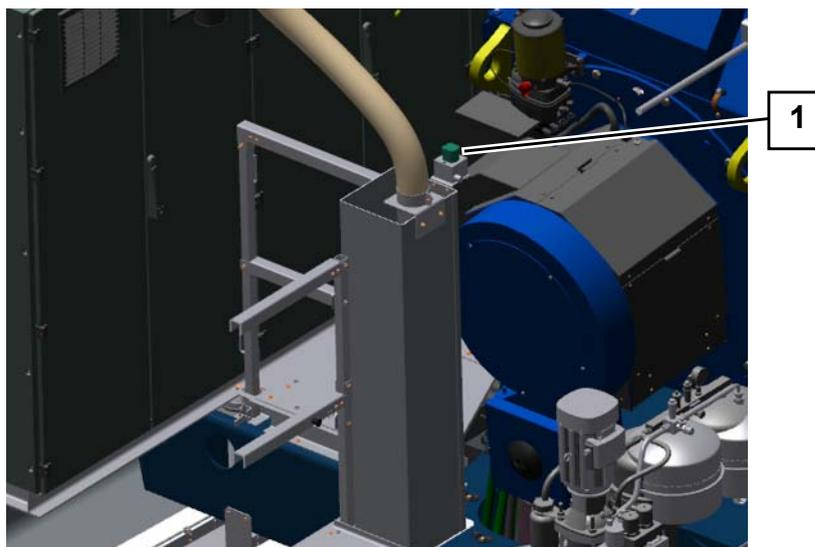
Abb. 20 Ausschalter Mittelspannung am Kettenkasten des Elektrokettzugs
