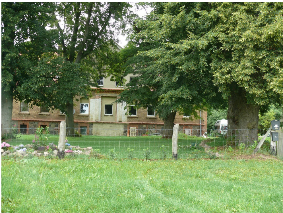
Foto IP 07, Thurow, Ringstr. 19/20/21 Blick von Südosten
