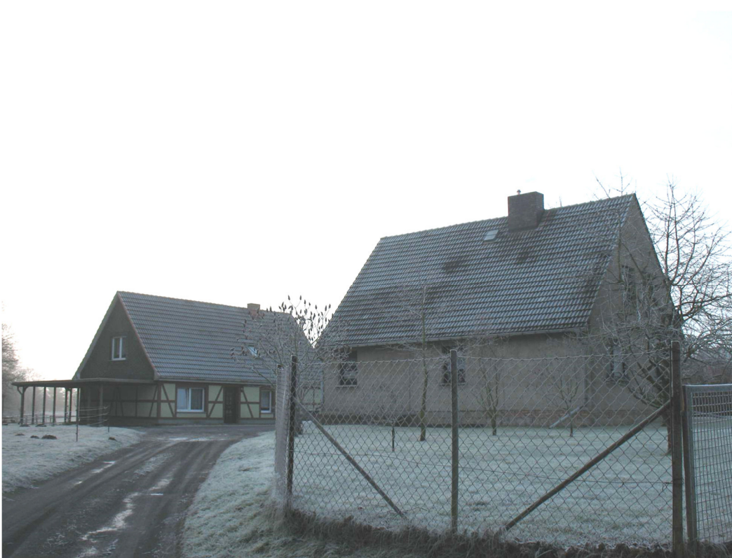
IP 02 Dambeck, Chausseestr. 20, Hinterhaus
