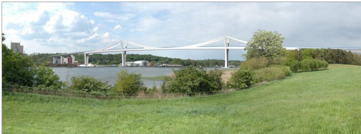
Abbildung 12: Visualisierung Bauwerk 5 - Zügelgurtbrücke
