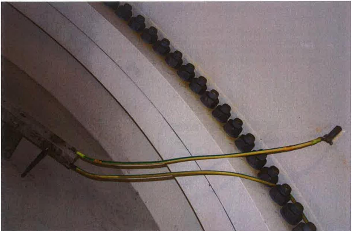
**Abbildung 3.9: Verbindung zwischen dem Turm und der Haupterdungsschiene**
