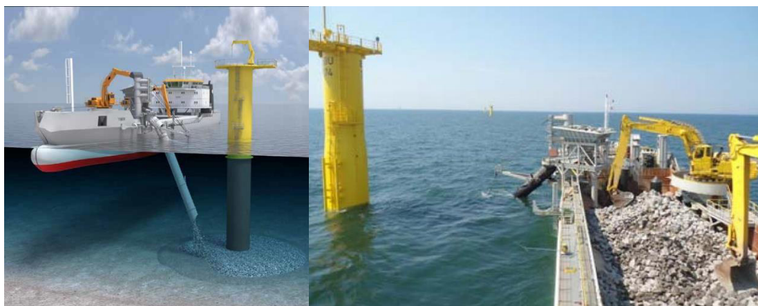
Abb. 2: Beispiel eines Fall-Pipe Vessels, Einsatz beim OWP Butendiek; Quelle: www.heavyliftnews.com / Jan de Nul
