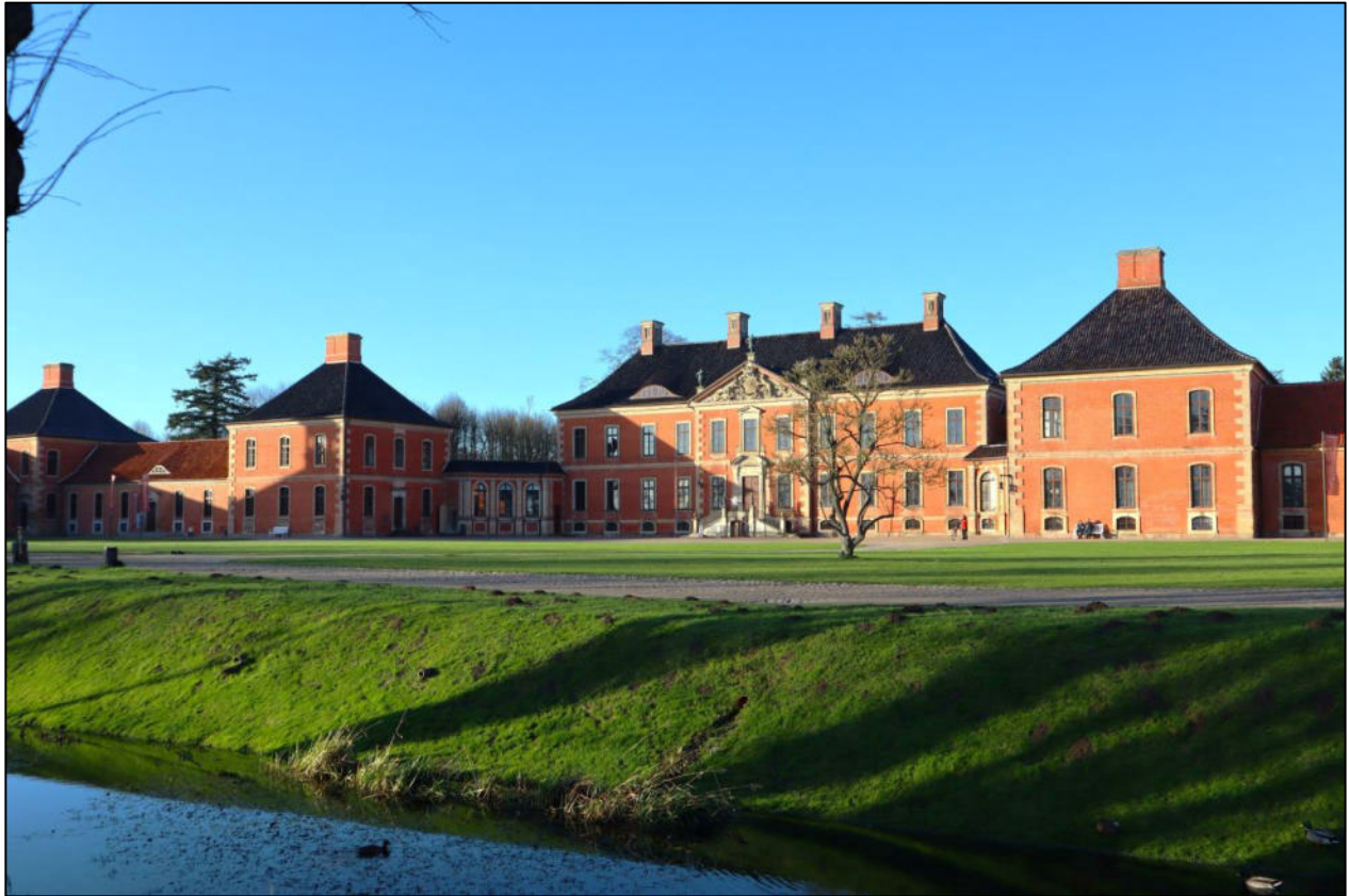
Abbildung 1: Schlossanlage Bothmer, Nordwest-Ansicht (Foto: WIND-projekt, 16.12.2021)
