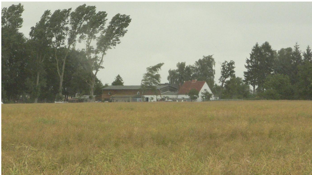
Abb. 3: Detailansicht des Gebäudes „Landstraße 21“ (BP im Südwesten)
