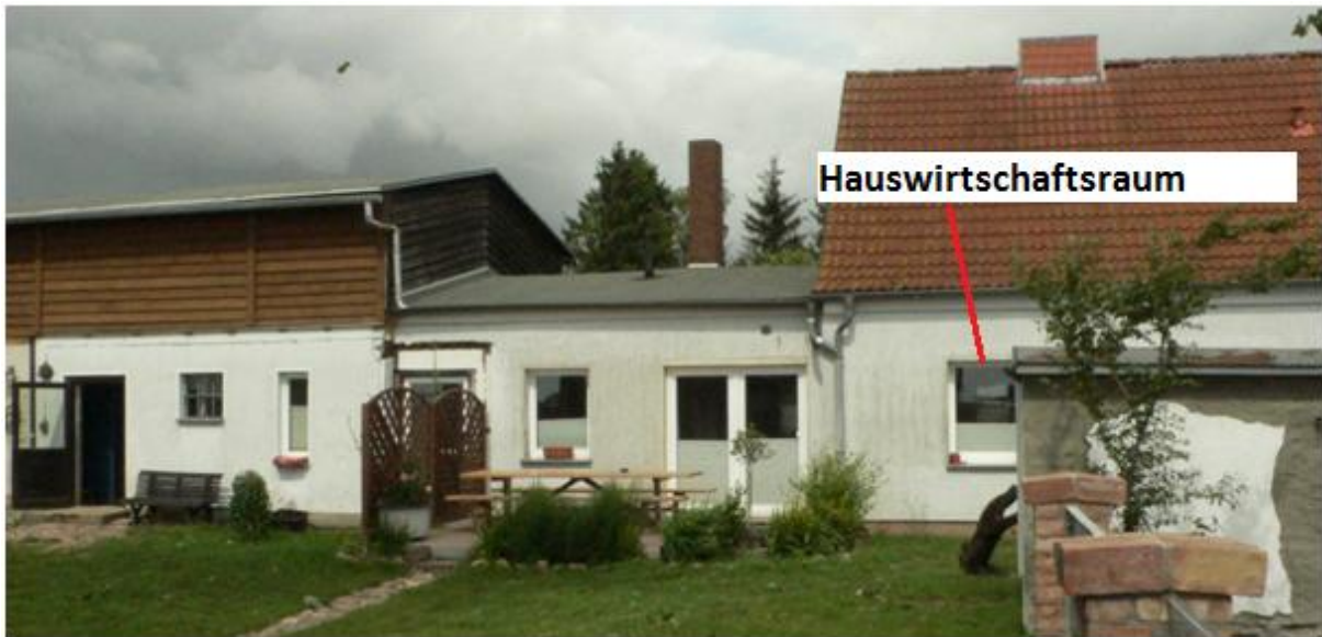
Abb. 4: Detailansicht des Gebäudes „Landstraße 21“ - Terrasse (BP im Südwesten)
