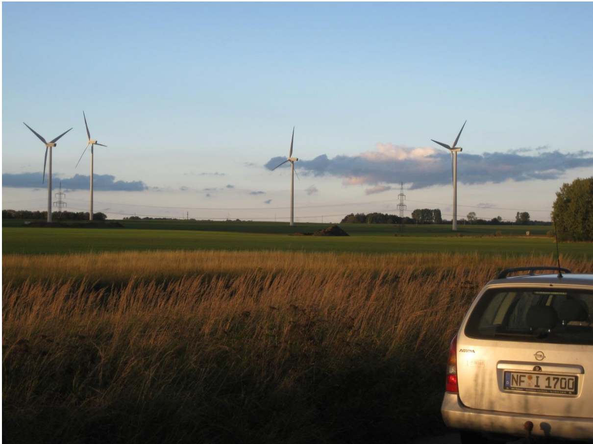
Abbildung 6.2: Blick auf die Bestandsanlagen am süd-östlichen Ende des Windparks
