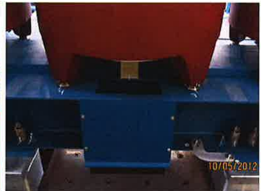
Abbildung 24–9: Basic+ ohne untere Stützblöcke
