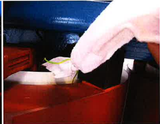
Abbildung 26–13: Die Mittelspannungswicklung en reinigen
