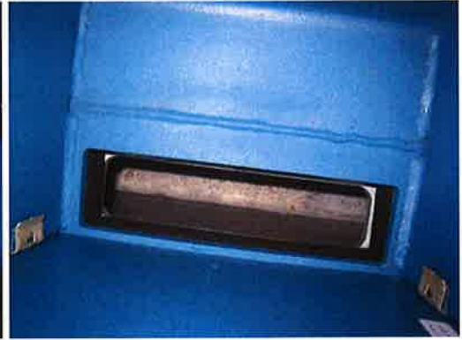
Abbildung 22-4: Lufteingang vom Fundament
