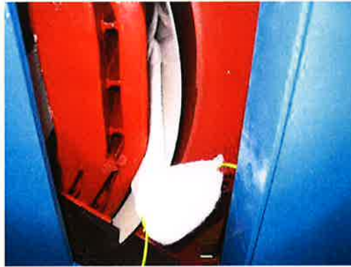
Abbildung 26–17: Die Niederspannungswicklungen reinigen
