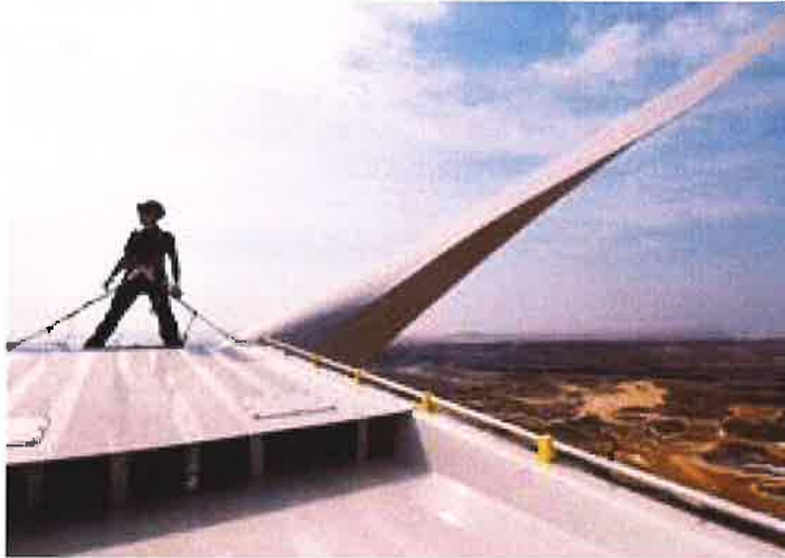
Abbildung 11-1: Arbeiten auf dem Maschinenhaus
