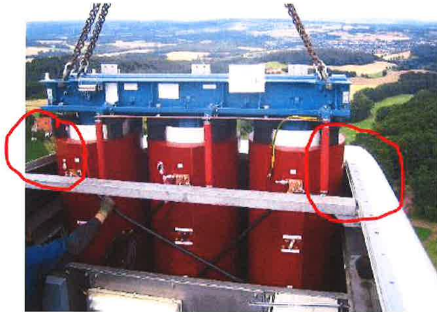
Abbildung 19-1: Führen des Transformators in das Maschinenhaus
