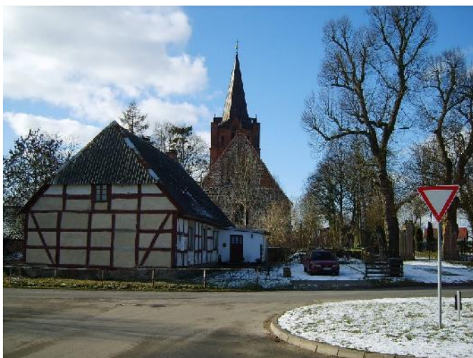
Abbildung 26 Fachwerkwohnhaus in Ranzin
