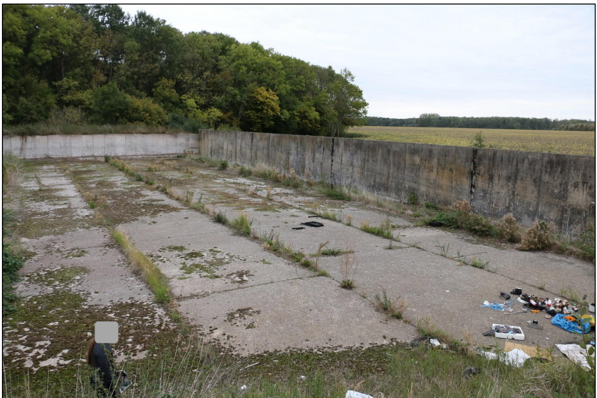
Abbildung 20: Blick auf das Silage-Silo der „Kompensation 4“ von Süden.
