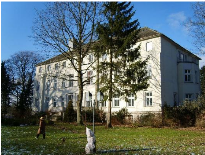
Abbildung 28 Gutsanlage mit Gutshaus in Ranzin
