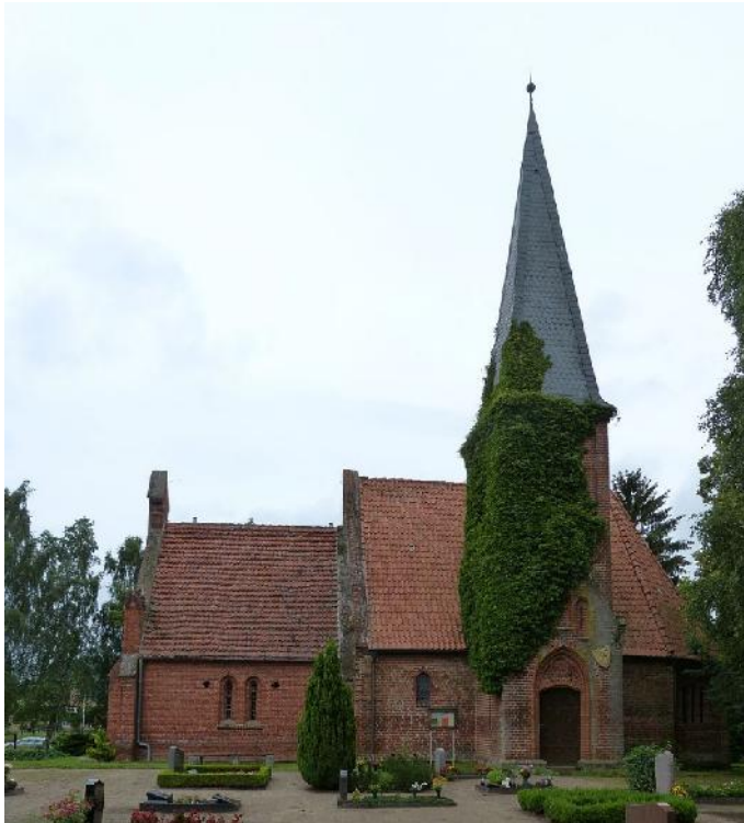
Abbildung 15 Südseite der Kirche Lüssow
