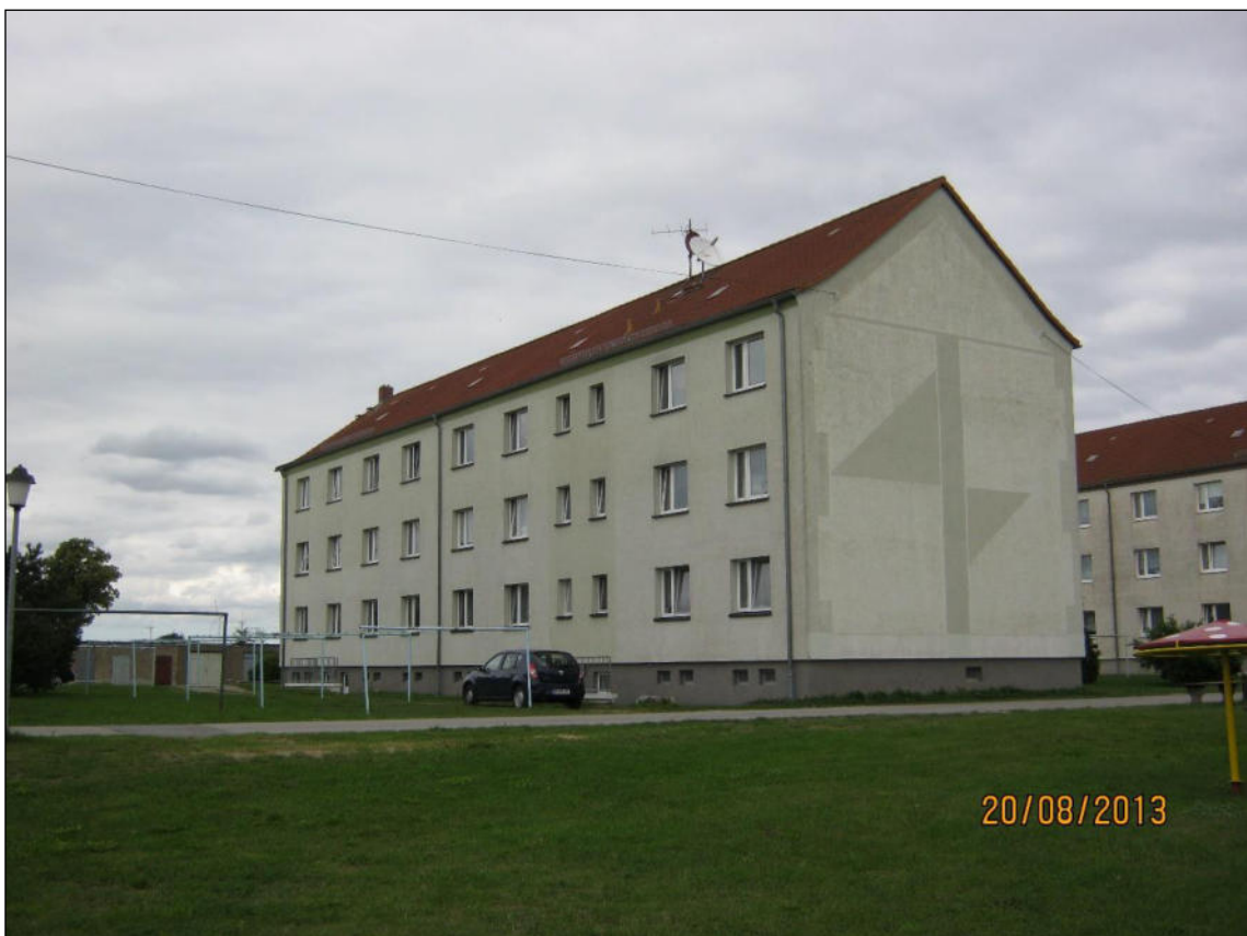
Abb. 8: Blick von Südwesten auf SR 050, Siedenbrünzow, Ziegenstraße 13/14
