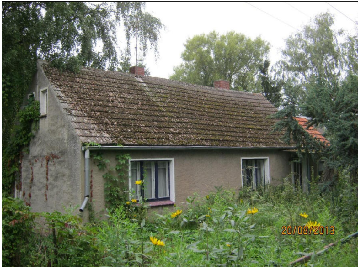
Abb. 1: Blick von Südosten auf SR 016, Eugenienberg, Zur Hasenkühle 1, z. Zt. Unbewohnt
