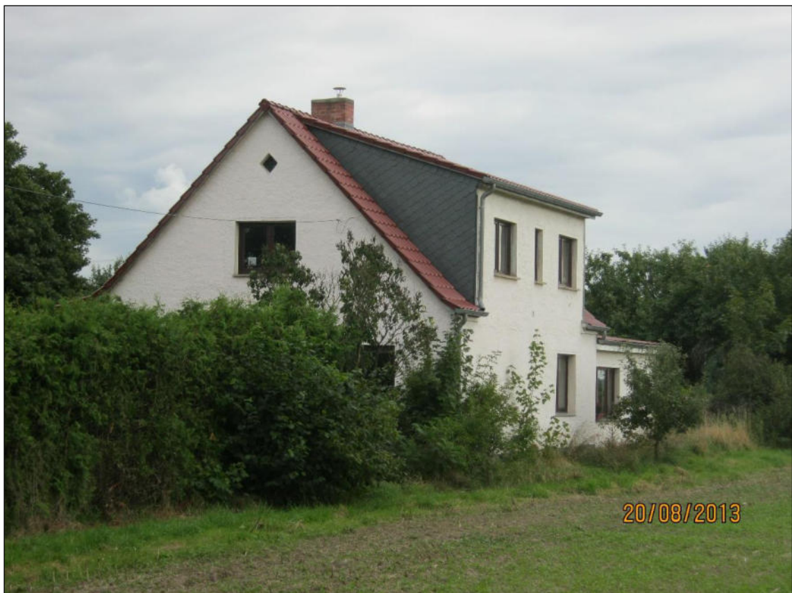
Abb. 4: Blick von Nordwesten auf SR 034, Quitzerow, Siedlung 20
