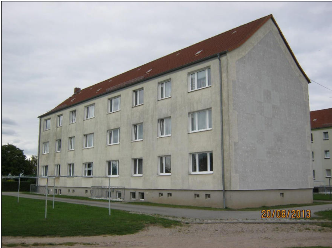
Abb. 7: Blick von Südwesten auf SR 049, Siedenbrünzow, Ziegenstraße 11/12
