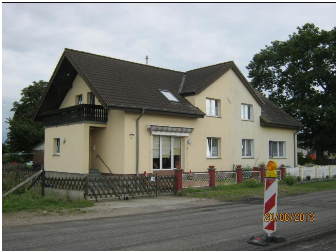
Abb. 6: Blick von Nordwesten auf SR 040, Siedenbrünzow, Dorfstraße 1 und 2
