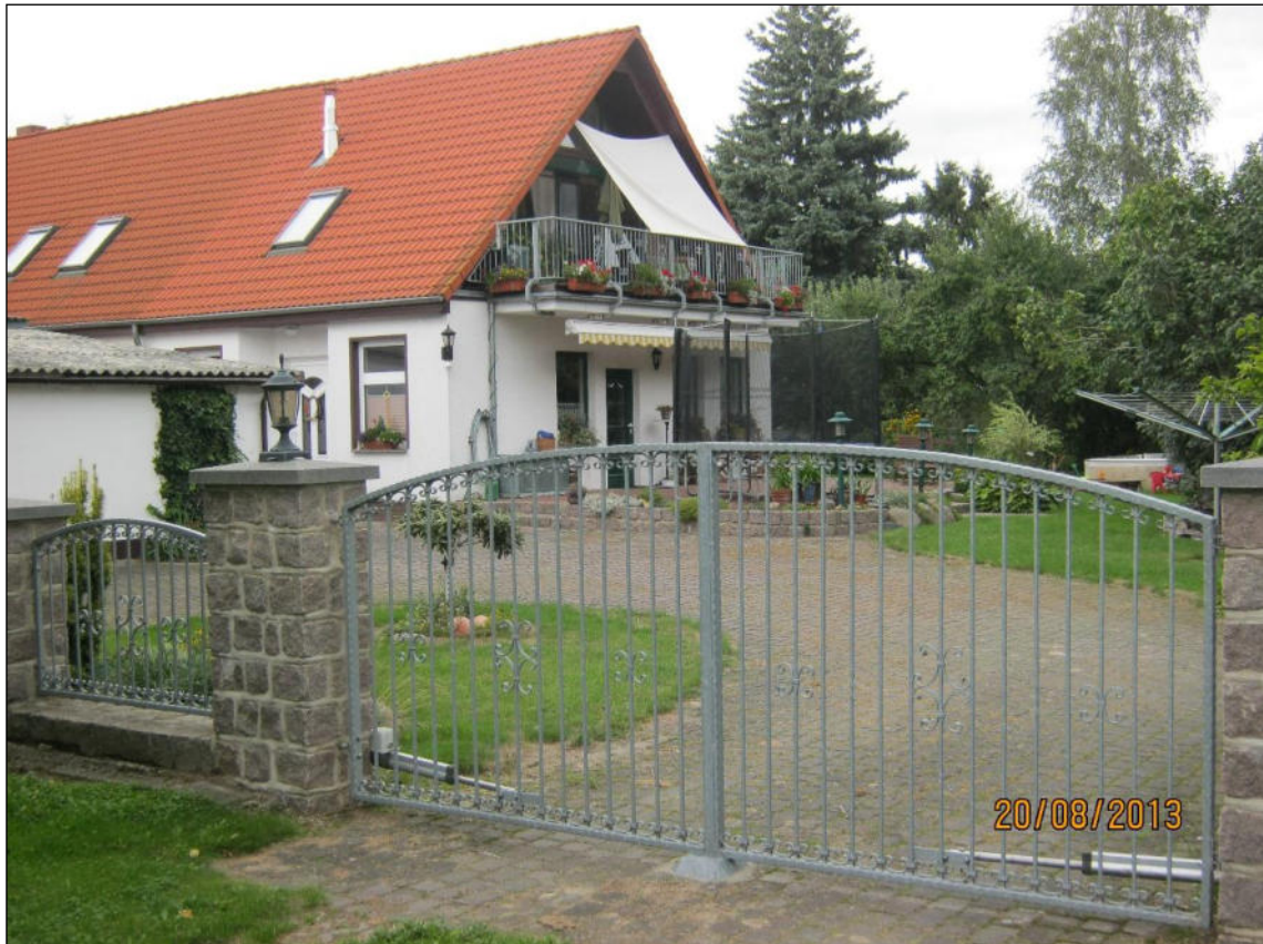
Abb. 9: Blick von Südosten auf SR 053, Siedenbrünzow, Zum Umspannwerk 1
