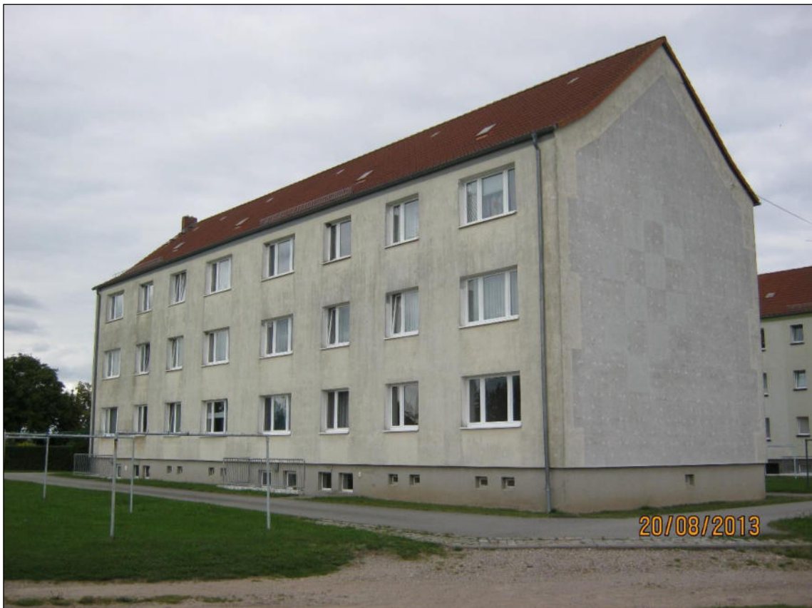
Abb. 8: Blick von Südwesten auf IP 09, Siedenbrünzow, Ziegenstraße 11/12
