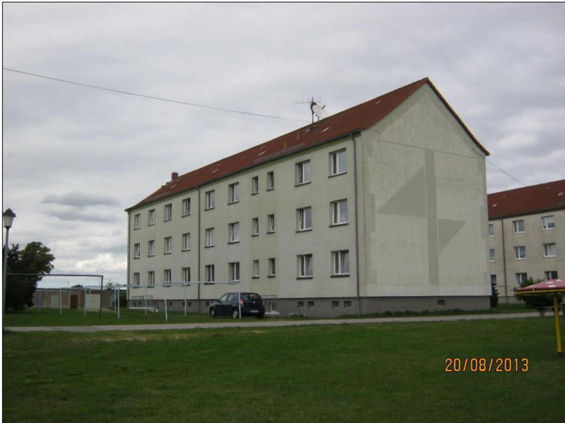
Abb. 7: Blick von Südwesten auf IP 08, Siedenbrünzow, Ziegenstraße 13/14
