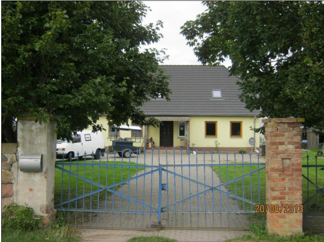
Abb. 5: Blick von Süden auf IP 05, Siedenbrünzow, Dorfstraße 34
