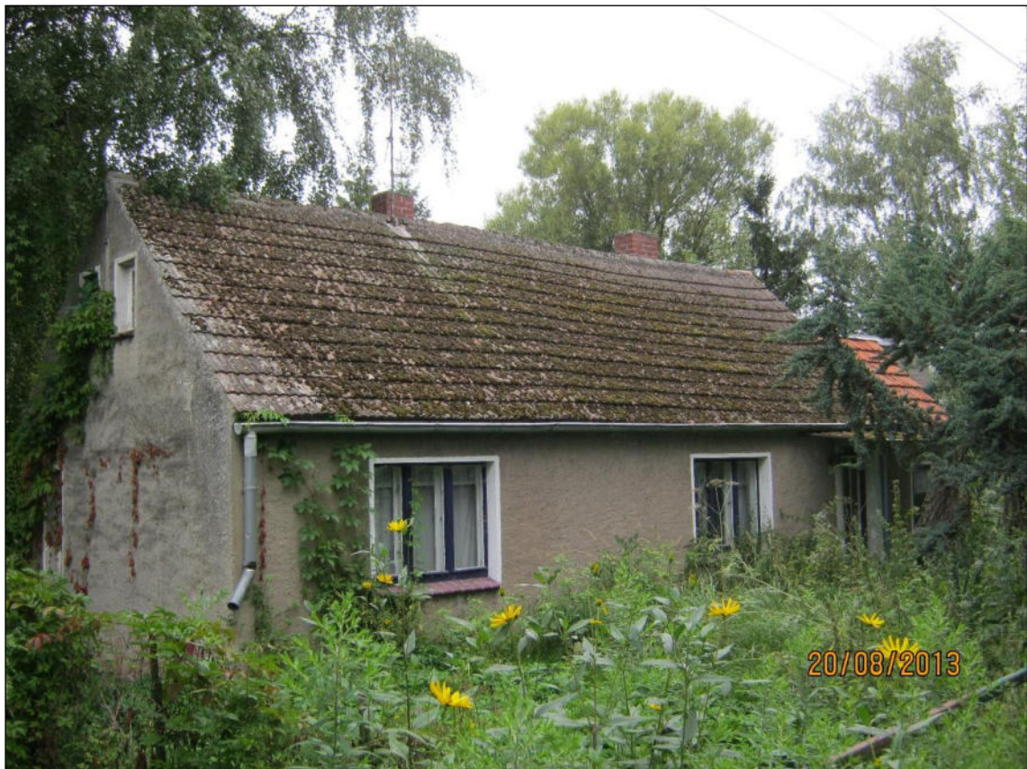
Abb. 10: Blick von Südosten auf IP 11, Eugenienberg, Hasenkuhle 6, z. Zt. unbewohnt
