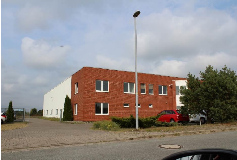
I: Parkstr. 8, Lübesse (Dräger Maschinenbau GmbH)
