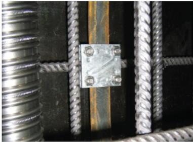
Abb. 9: Verbindung Blitzschutzroten mit Bewehrung
