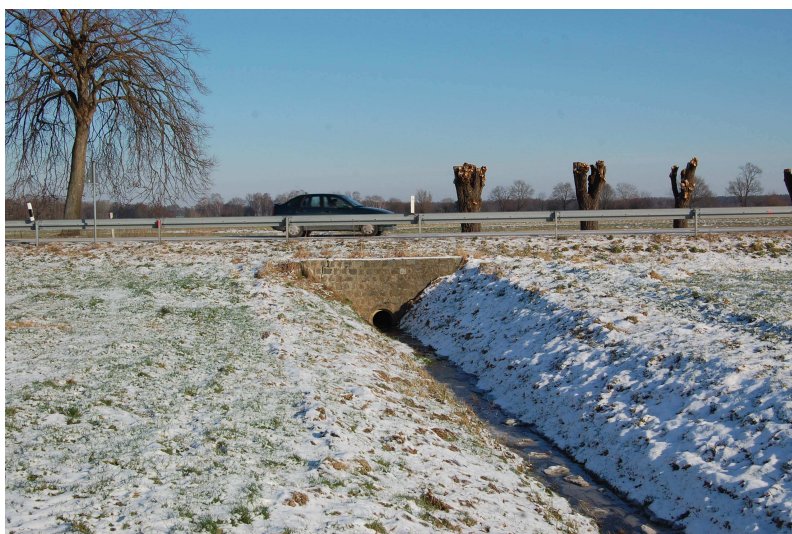
Abb. 5: Derzeitige Situation am Gefahrenpunkt 4
