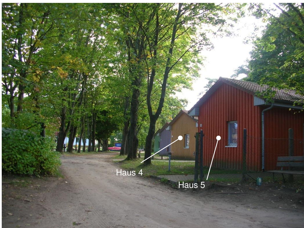
Bild 2: Jugendherberge Haus 5 (Nordfassade) und Haus 4 Nordfassade
