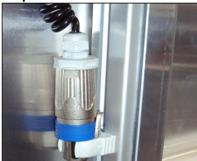
Ist die Podesttür ordnungsgemäß geschlossen, stecken Sie den Anschlussstecker wieder in die Halterung im Lift.
