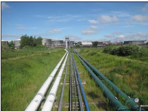
**Foto 7: Blick entlang der Rohrtrasse auf die Rohrbrücke. Im Bestand werden weitere Rohrleitungen verlegt, die Rohrbrücke verlängert.**
